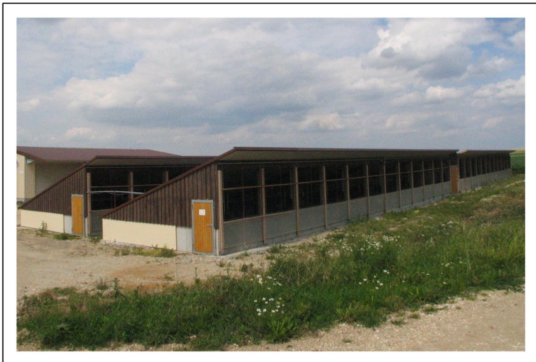
Abbildung 6: Außenklimastall (Quelle: JAIS, 2007)
