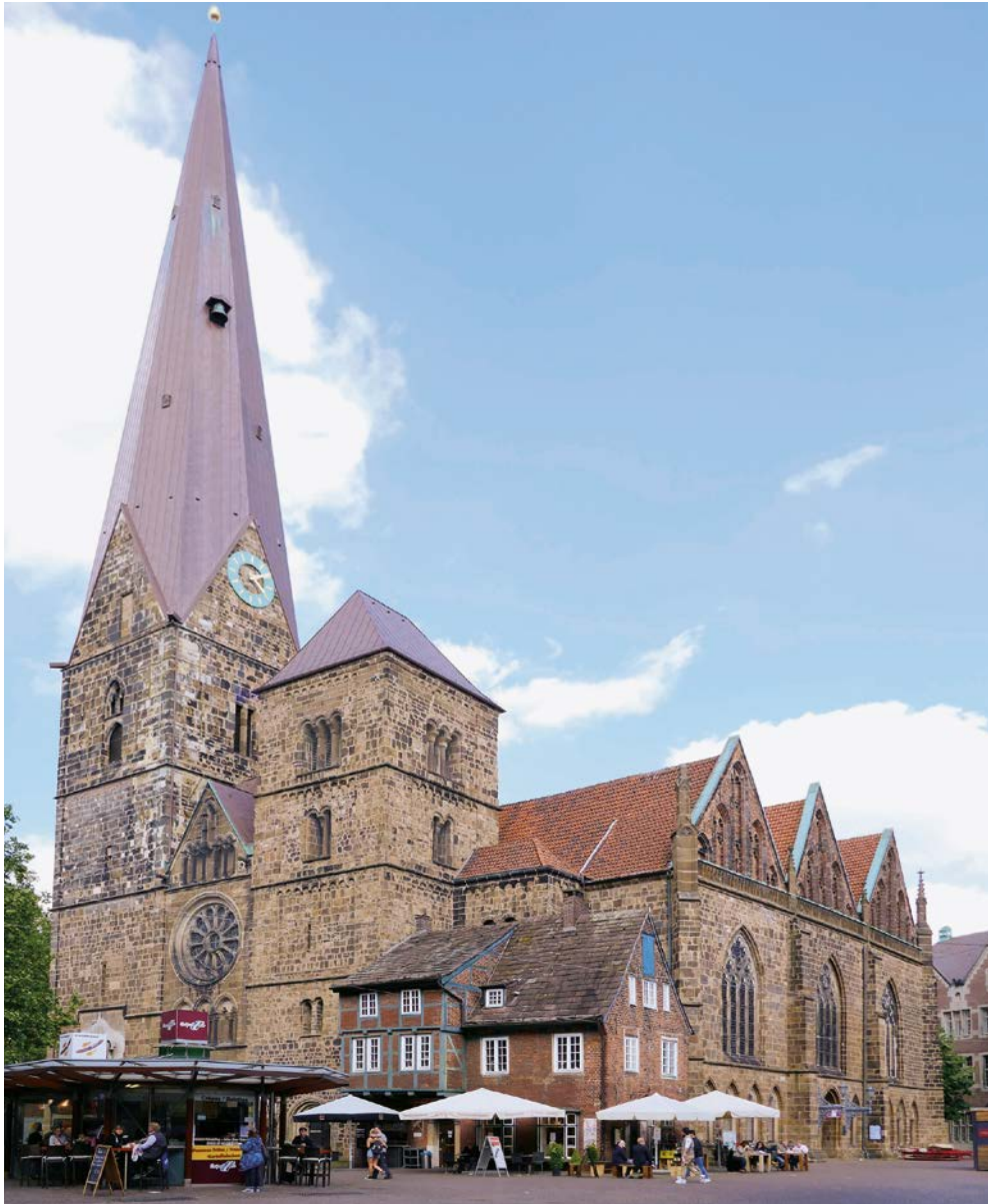
Abb. 1: Unser Lieben Frauen: aktuelle Ansicht von Südwest
