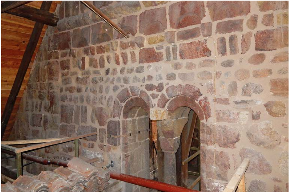
Abb. 5: Unser Lieben Frauen, Südturm Nordseite
