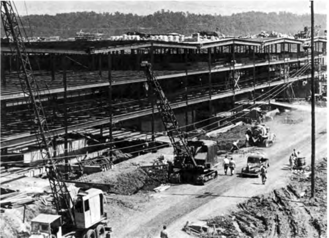
K-25 STEEL-FRAME CONSTRUCTION
