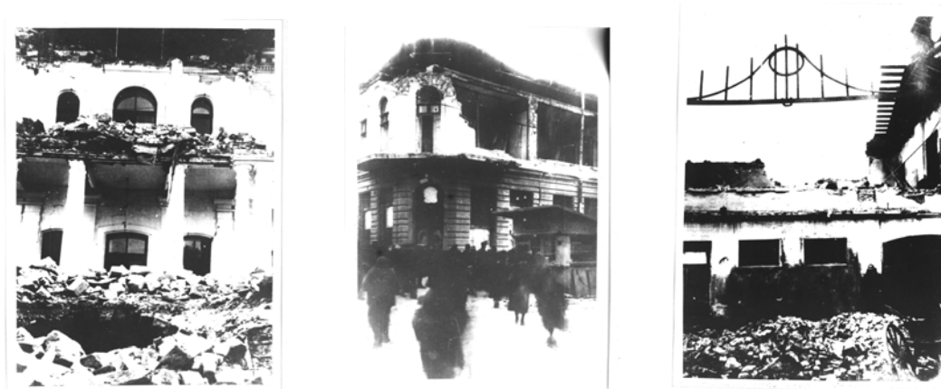
Fig. 1. Clădiri avariate de cutremurul din 10 noiembrie 1940 în Chișinău
