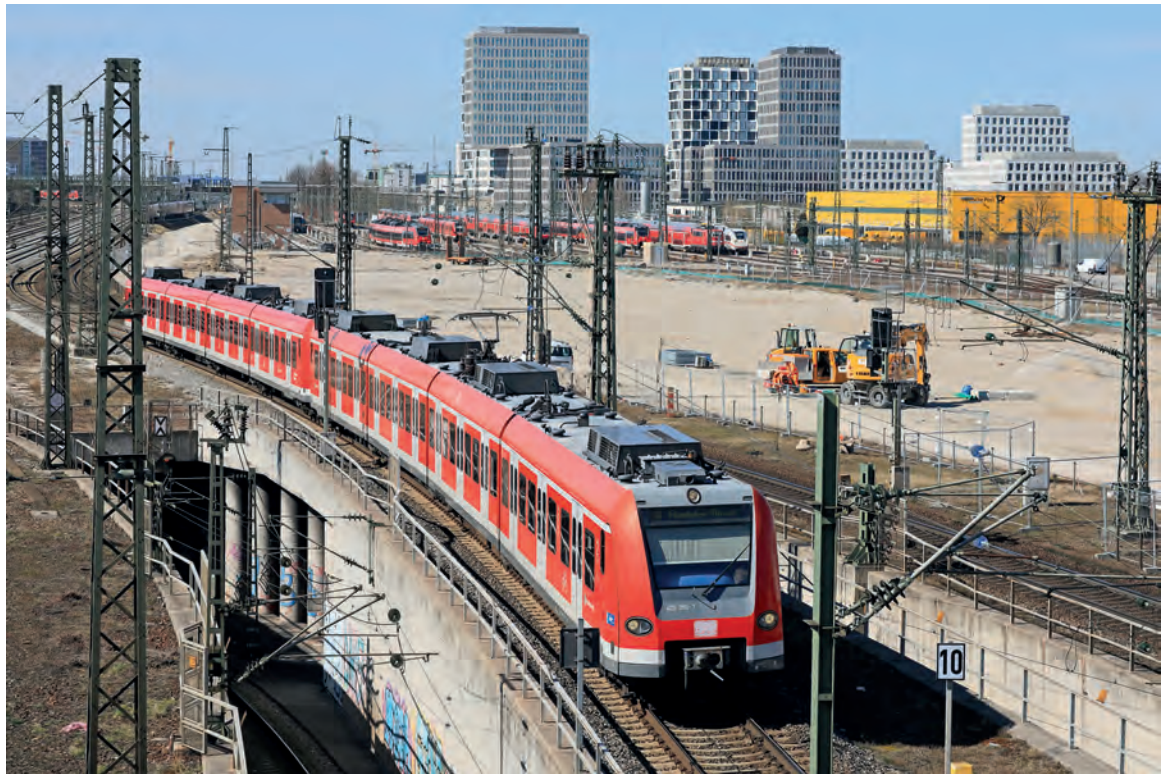
Bild 1: Ein Vollzug, gebildet aus zwei Triebzügen der BR 423 der S-Bahn München, fährt in den Bf. Donnersbergerbrücke ein; die Freifläche im Hintergrund ist Baustelle für den 2. Stammstreckentunnel (Foto: DB/Uwe Miethke).
