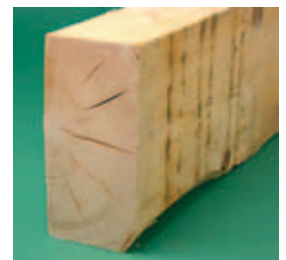
Abbildung 2.17: Innenrisse in einem Fichtenkandholz aufgrund zu scharfer Trocknung.
