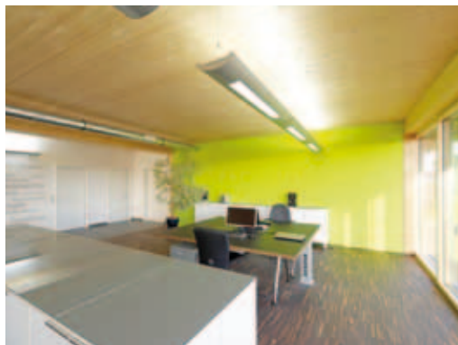
Abbildung 6.5: Flachdachkonstruktion aus Brettstapel - Elementen
