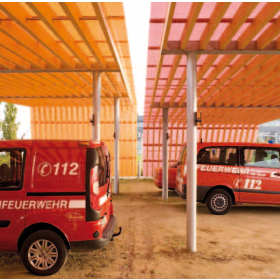
Abbildung 3.2: Dachkonstruktion des Carport der Berufsfeuerwehr Frankfurt am Main
