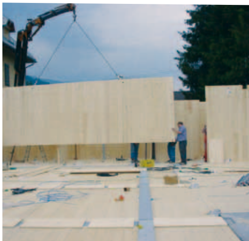
Abbildung 4.34: Hotelbau in Monte Sella unter Verwendung von Brettspertholz
