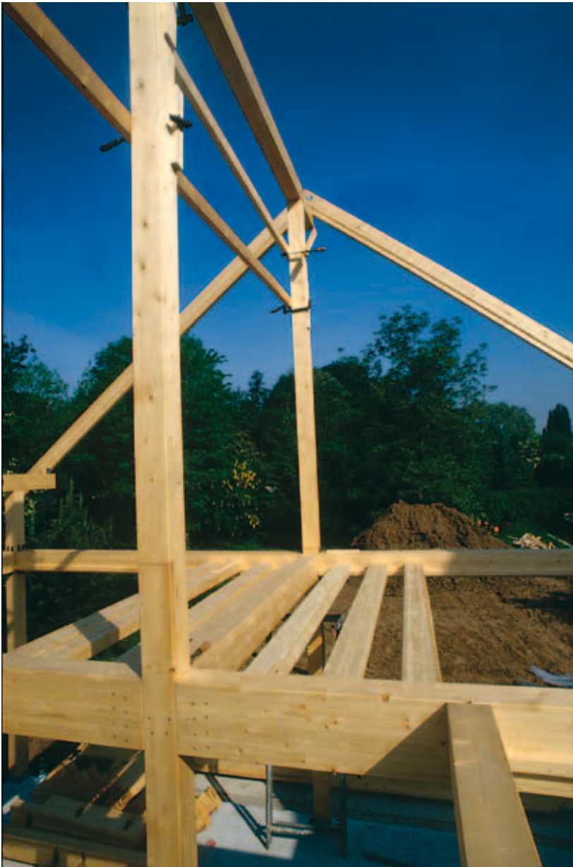
Abbildung 4.14: KVH® in der Dachkonstruktion
