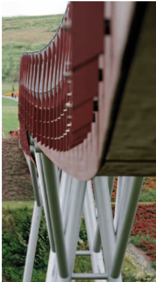
Abbildung 6.14: „Drachenschwanzbrücke“ über das Gessental in Ronneburg
