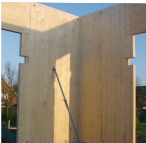
Abbildung 4.33: Brettspertholz als Grund- konstruktion für einen Kin- dergarten in Sendenhorst
