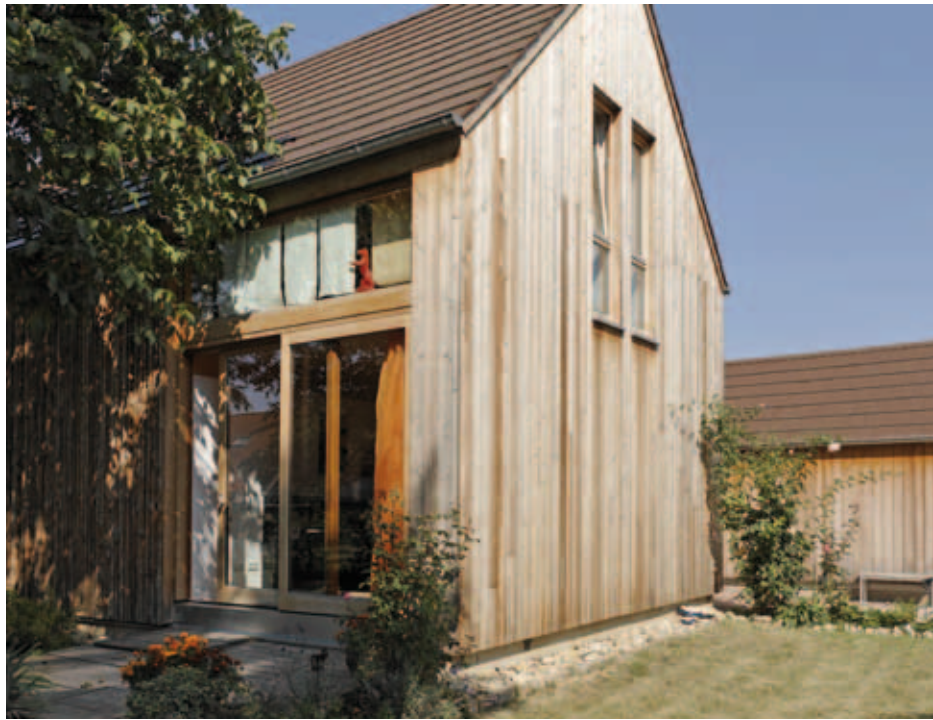
Abbildung 5.7: Ordnungsgemäß verlegte Schalung, kein Holzschutz- mittel erforderlich.
