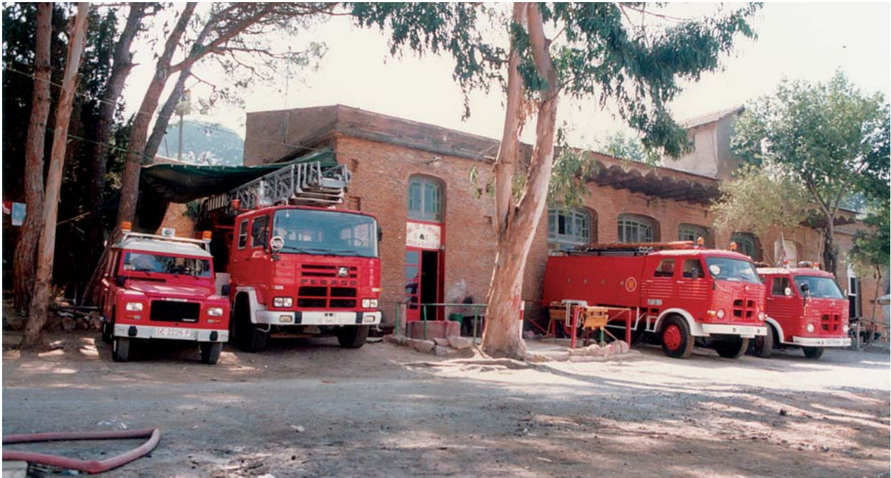
El parc de bombers de Sant Feliu de Guíxols amb diversos vehicles preparats especialment per accions d'extinció d'incendis forestals, molt habituals a les muntanyes del litoral de Girona. © Arxiu Regió d'Emergències de Girona
