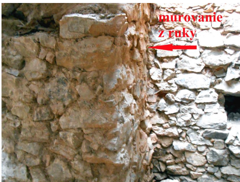
Obr. 182 Oporný pilier v delovej bašte Tereš zo začiatku 17. storočia. Stav v roku 2017 (autor).
