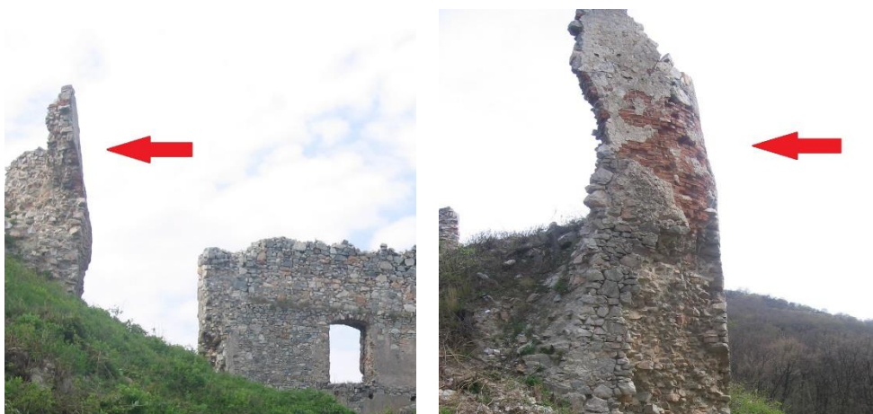
Obr. 176 Kónickosť nárožia horného hradu (autor).
