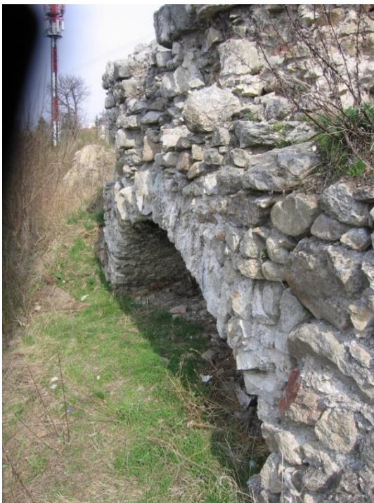
Obr. 23 Vyľahčovací oblúk obvodovej hradby (autor).
