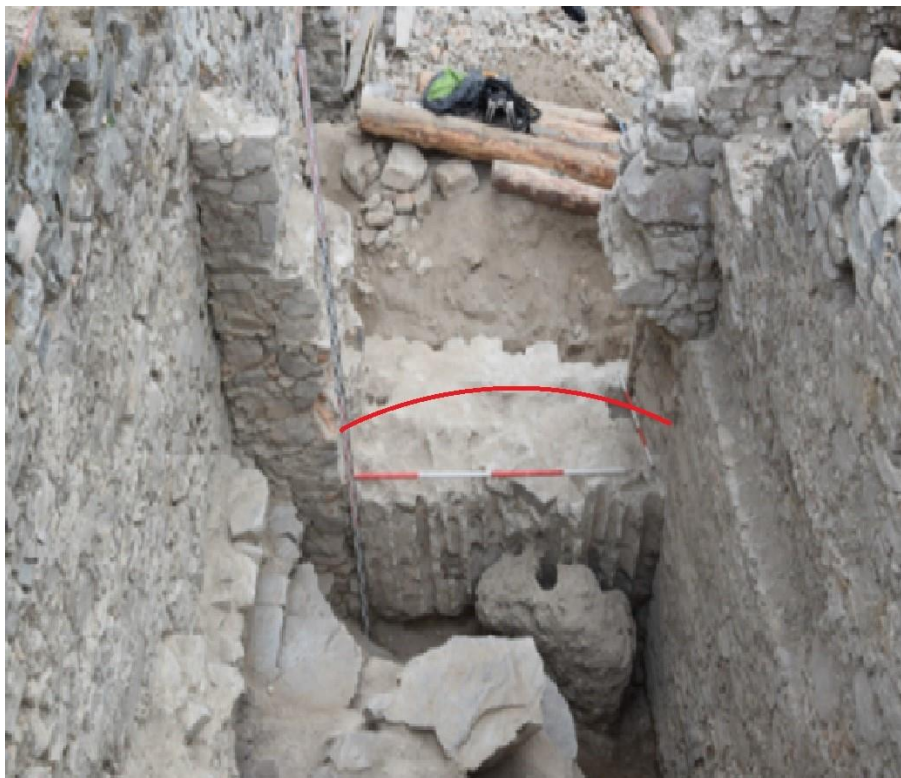
Obr. 172 sekundárne zamurovaný dverný otvor s naznačením pôvodného klenbového pásu (podľa Repka/Styk/Šimunková 2017, obr. 55).
