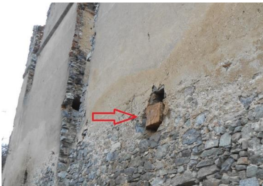
Obr. 59 Vystužovacia klieština v prízemí renesančného paláca (autor).
