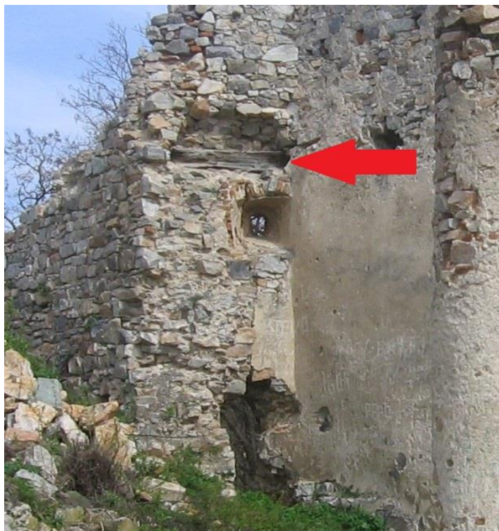
Obr. 72 Umiestnenie klieštiny medzi 2 hradbami (autor).
