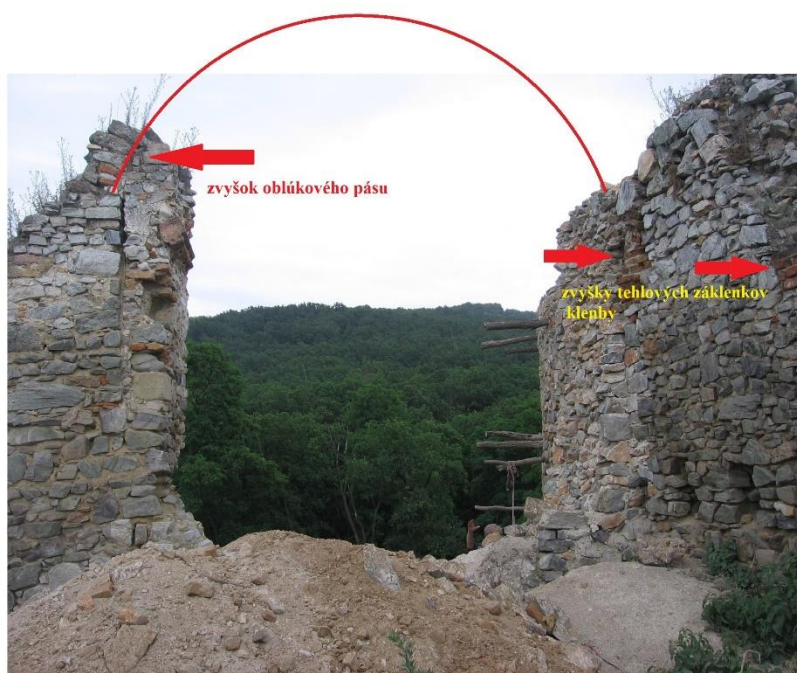
Obr. 39 Interiér miestnosti SV paláca II., severný pohľad (autor).
