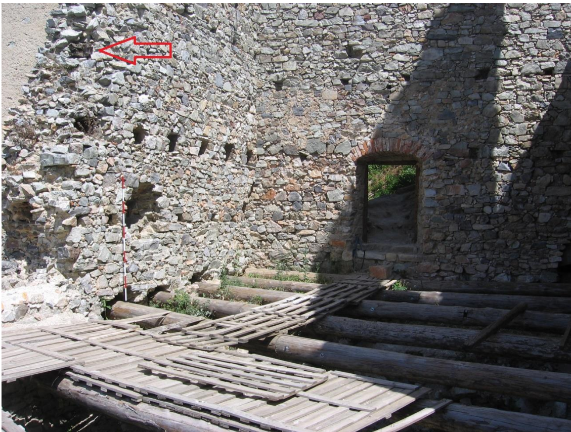
Obr. 68 Lokalizácia vystužovacej klieštiny (autor).
