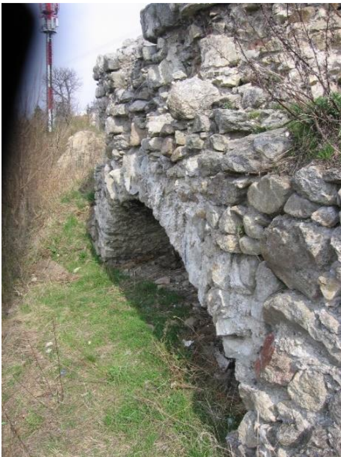
Obr. 168 Vyľahčovací oblúk obvodovej hradby (autor).
