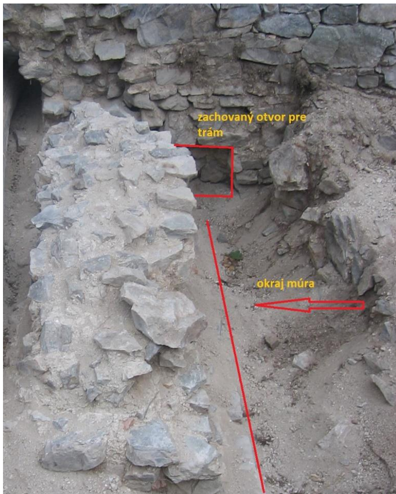
Obr. 177 Osadenie trámu za okraj múra (autor).
