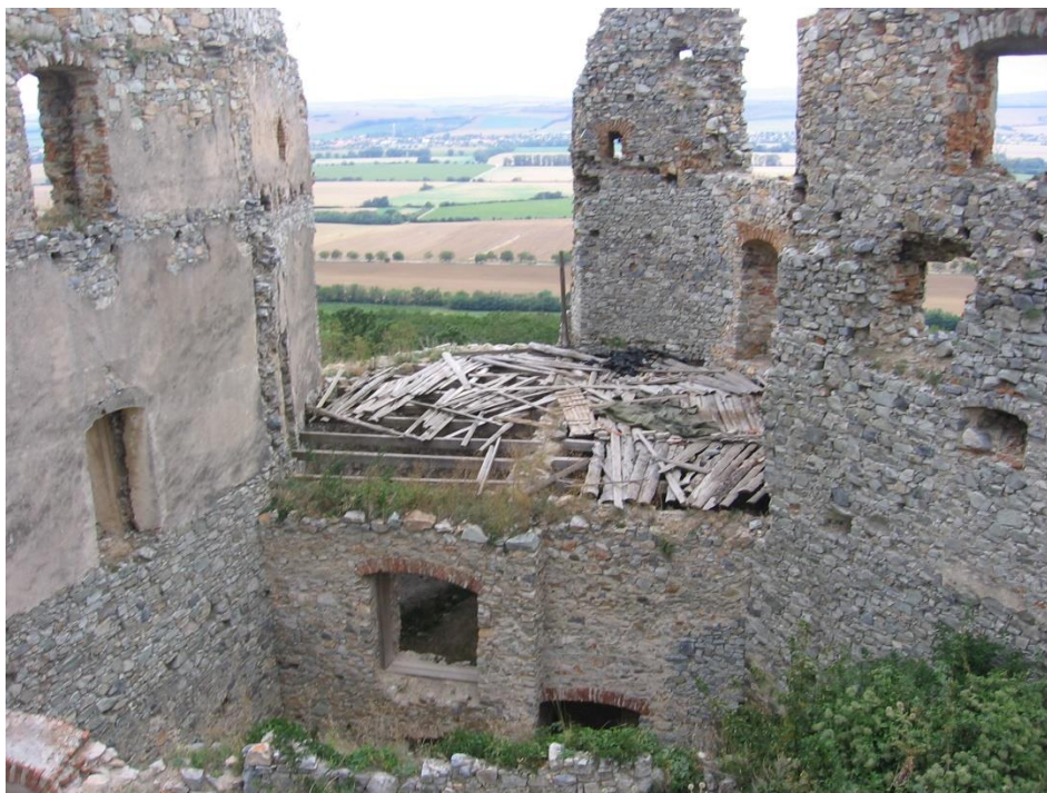
Obr. 56 Pohľad do interiéru delovej bašty (autor).
