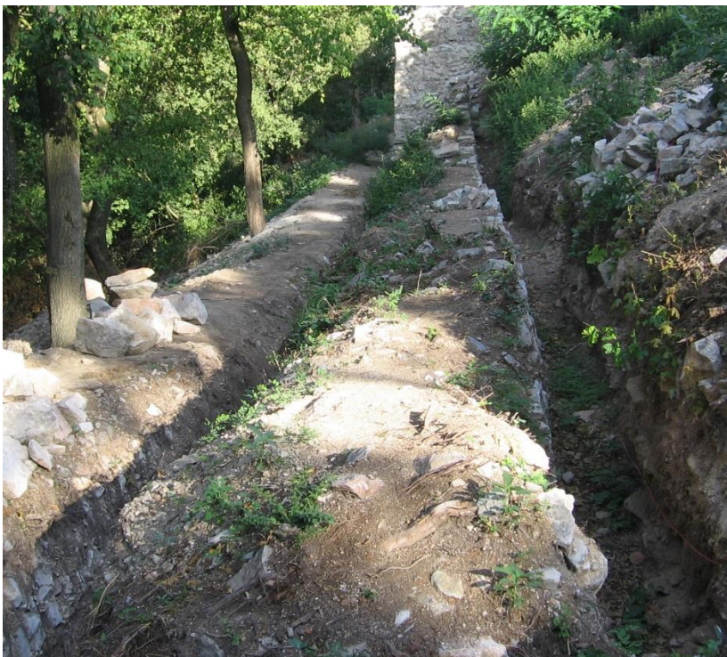
Obr. 74 Odkrytý úsek JZ obvodového múru (autor).
