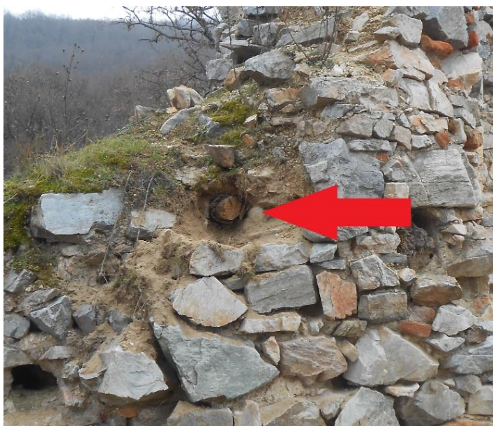
Obr. 83 Lokalizácia zvyšku dreva v obvodovej hradbe (autor).
