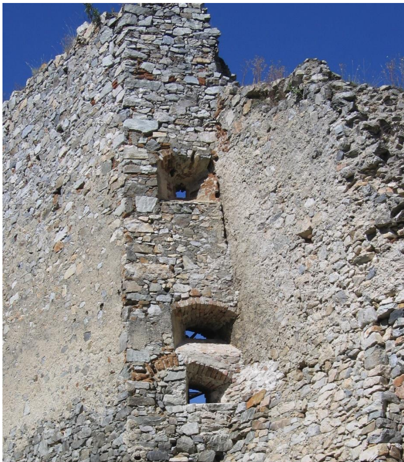
Obr. 79 Tri nad sebou umiestnené strieľne v spojnici obvodových hradieb (autor).
