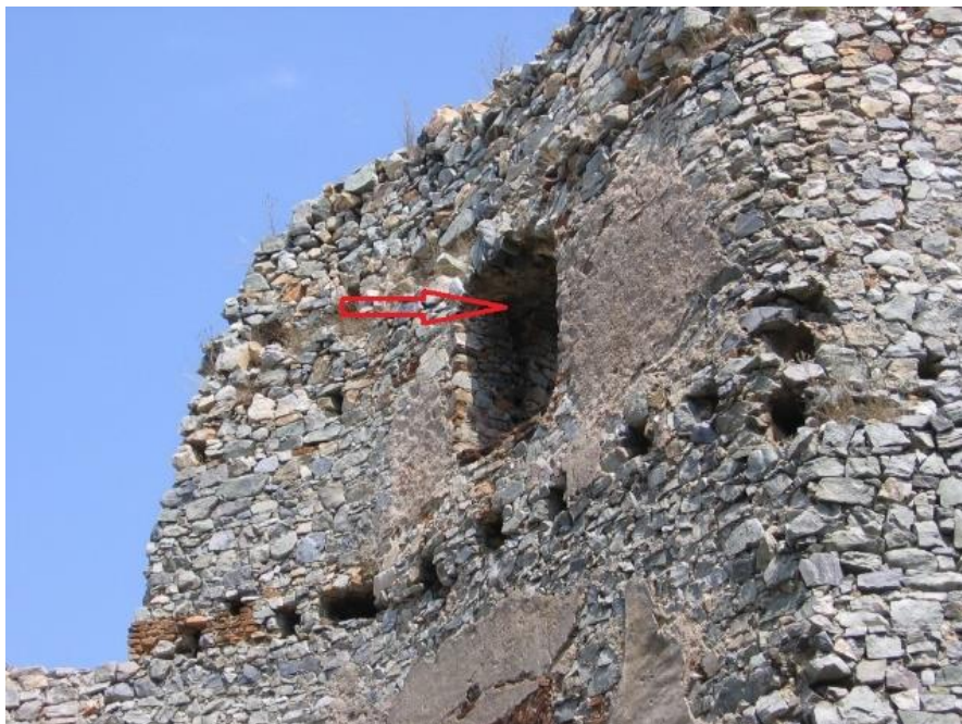
Obr. 54 Zvyšok okenného rámu na 4. podlaží delovej bašty (autor).
