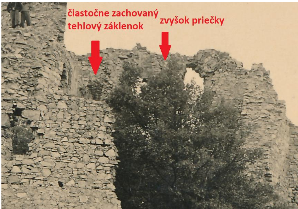
Obr. 40 Južný pohľad na objekt SV paláca II., (podľa archívu A. Selnekoviča).
