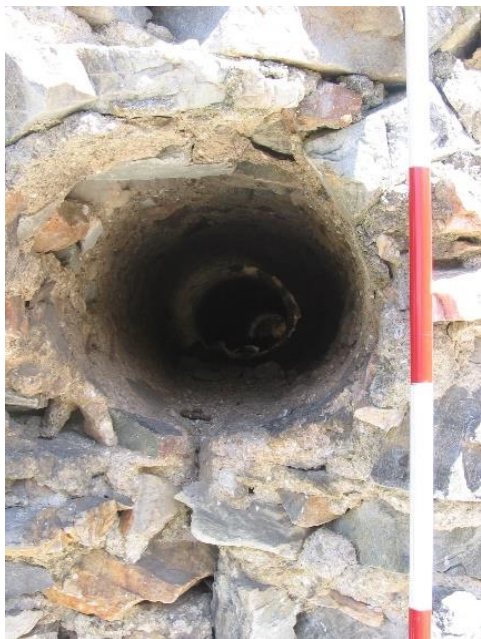
Obr. 189 Pozdĺžny otvor v hrúbke steny JZ renesančného paláca (autor).
