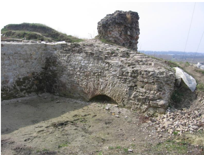
Obr. 24 Vyľahčovací oblúk nárožnej veže (autor).
