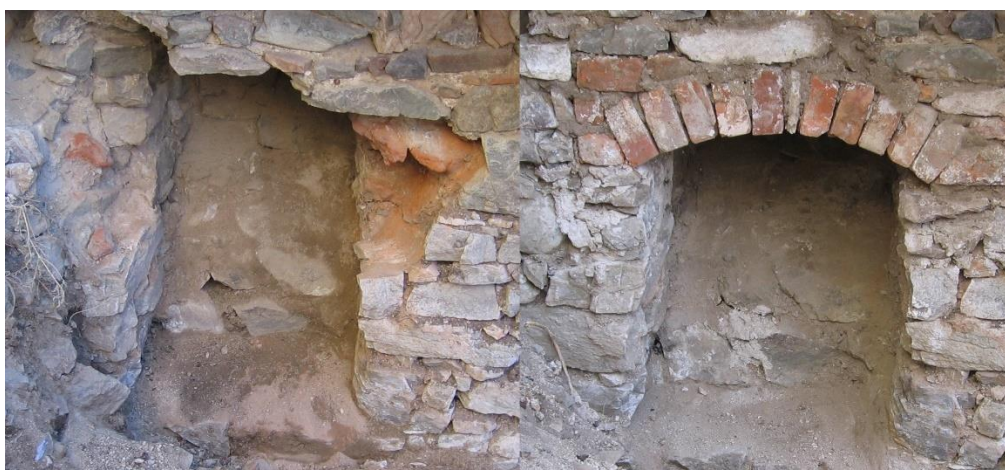
Obr. 70 Odvetrávací otvor, nálezový stav a stav po obnove (autor).
