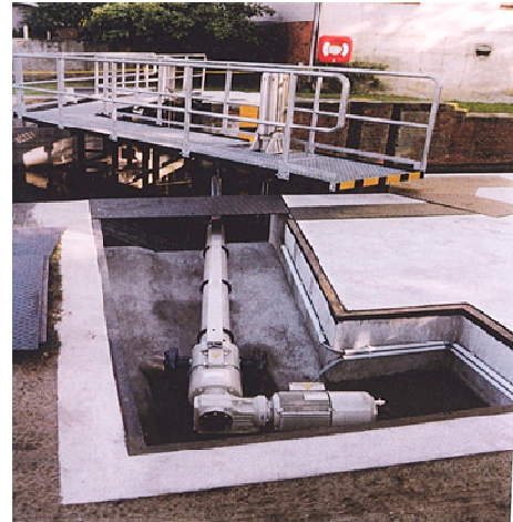
Elektrohubzylinder mit Antrieb
