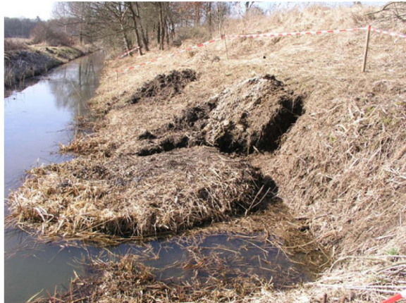
Bild 48: Biberschäden an der Havel (Quelle: WSV)
