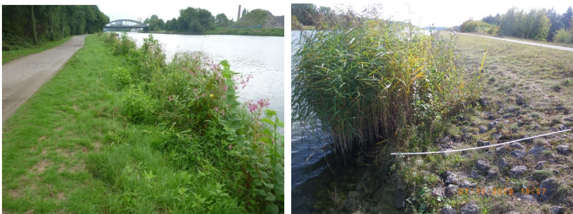
Bild 19: links: Hochstaudenflur am Rhein-Herne-Kanal (Quelle: BfG), rechts: Schilf auf Asphaltbetondichtung am MDK (Quelle: WSA Nürnberg)
