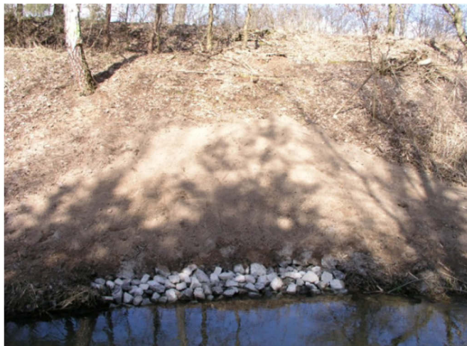
Bild 63: Verfüllter Biberbau an der Havel (Quelle: WSV)
