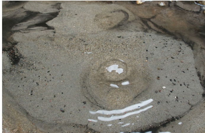
Bild 10: Quelltrichter in Bereich einer Seitengrabensohle (Quelle: WSA Meppen)
