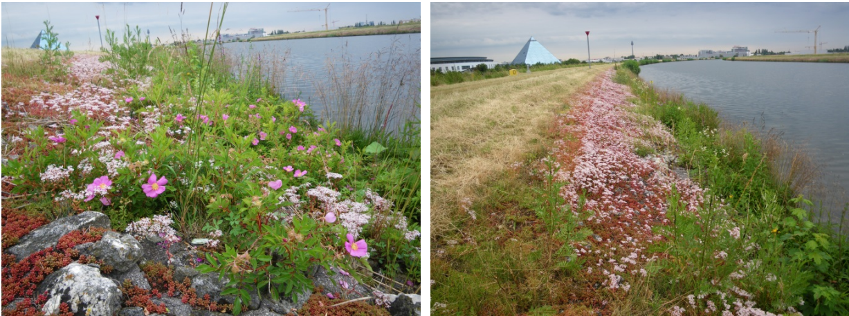
Bild 25: Tolerierbarer Bewuchs aus Fetthennen (weiß blühend) und weiteren Gräsern und Kräutern auf Raudeckwerk am MDK (Quelle: WSA Nürnberg)
