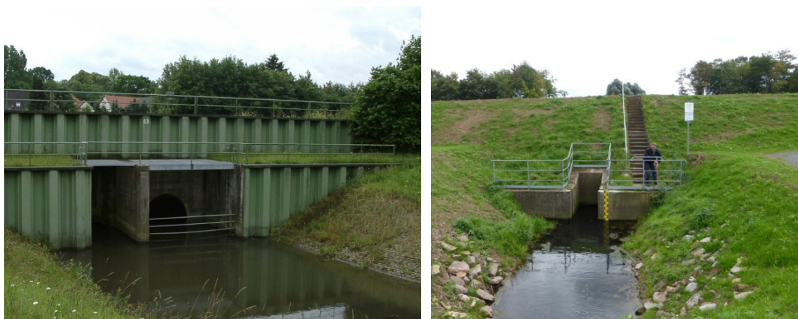
Bild 14: Auslaufbauwerk Düker 63 am MLK (links) und Auslaufbauwerk Riehebachdüker am Schleusenkanal Petershagen (rechts) (Quelle: BAW)
