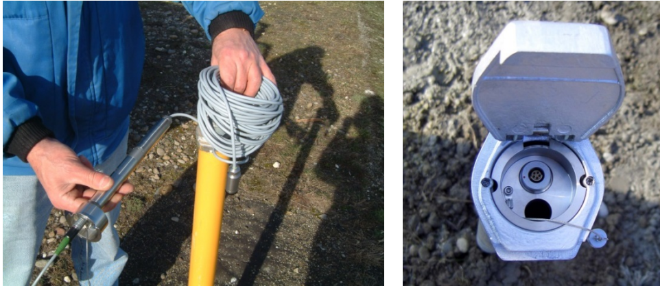
Bild 57: Pegelsonde vor (links) und nach dem Einbau (rechts) in eine Grundwassermessstelle (Quelle: BAW)
