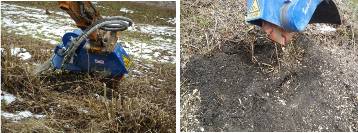
Bild 67: Wurzelstockentfernung mit Stockfräse am MDK (Quelle: WSA Nürnberg)
