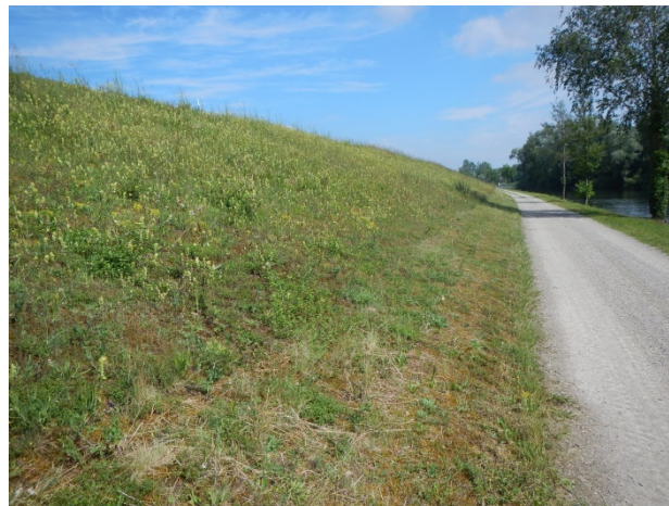
Bild 27: Magerrasen auf der landseitigen Böschung eines Stauhaltungsdammes am Oberrhein (Quelle: WSA Freiburg)
