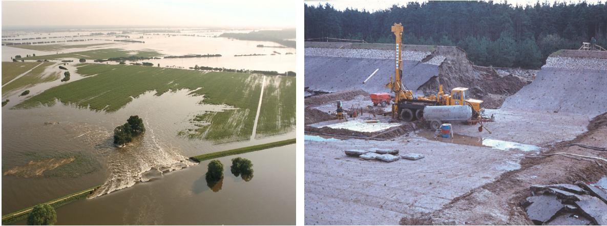
Bild 13: Bruch eines Deiches (links; Quelle: Helmholtz-Zentrum für Umweltforschung / André Künzelmann), Dammsbruch am Main-Donau-Kanal (rechts, Quelle: BAW)
