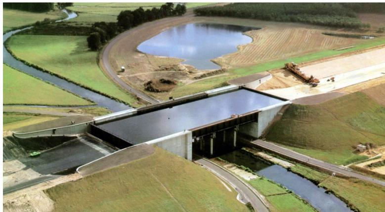
Bild 15: Kanalbrücke am ESK während des Baus (Quelle: WSA Uelzen)
