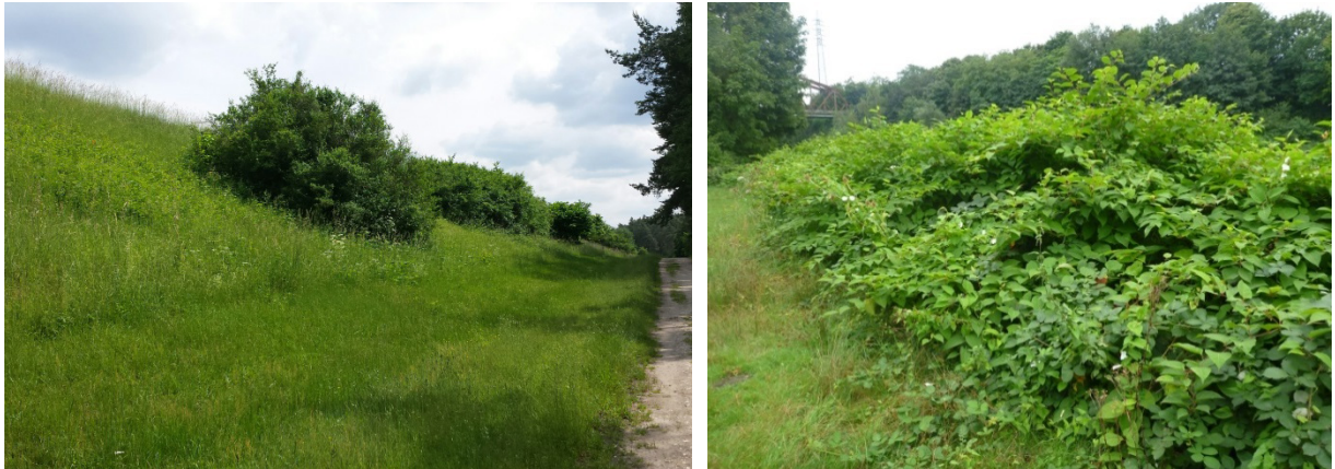
Bild 18: Geschlossene dichte Grasnarbe und zulässige Gehölze auf einer landseitigen Dammböschung des Main-Donau-Kanals (links, Quelle: WSA Nürnberg), Japan-Knöterich am Rhein-Herne-Kanal (rechts, Quelle: BfG)
