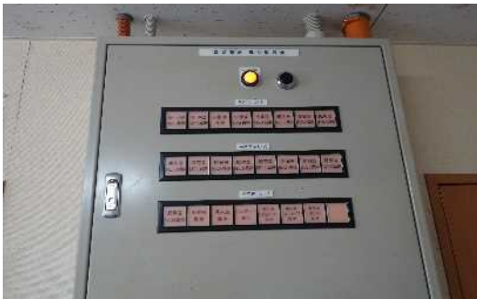
(左) 農場全体の警報異常監視システム (右) 農場内の換気コントロール制御基盤
