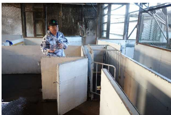
(左) 体重計測の際の追い込みスペース
