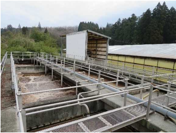
(左) 連続式活性汚泥浄化槽は、処理能力にかなり余裕も持たせて設計されている。処理水の透視度は 25 cm ほどあり、希釈せず川に放流している。 (右) 汚泥脱水機
