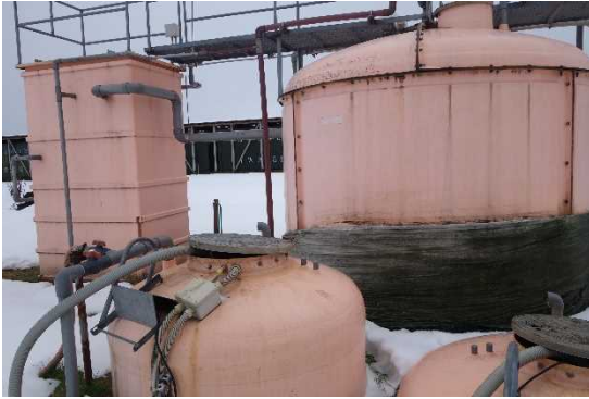
(左) コンパクトな設計の膜分離方式の浄化槽
