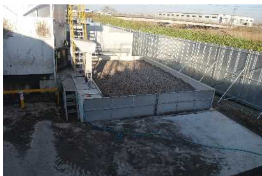
(左) 従来のチップ式脱臭装置
