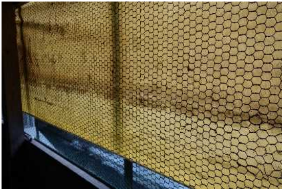
(左) 豚舎の開口部はすべて目の細かい金網を張っている (右) 離乳舎、分娩舎の飼料タンクは2本ずつ配置し、パイプラインで流す。肥育舎も1棟当たり前期と後期2本ずつの配置。
