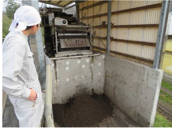
(左) 連続式活性汚泥浄化槽は、処理能力にかなり余裕も持たせて設計されている。処理水の透視度は 25 cm ほどあり、希釈せず川に放流している。 (右) 汚泥脱水機
