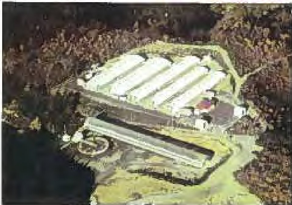
(有)田代ファーム豚舎等施設(昭和62年10月)の概舎等施設
