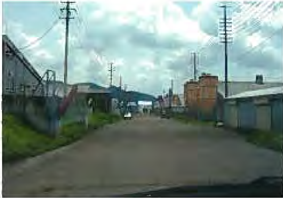
〈右〉「和田湖高原ファーム豚舎等施設群」正面に見えるのが豚の道路横断閉閉橋
