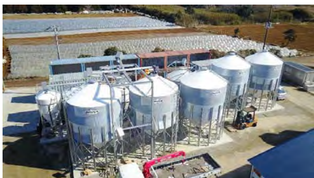
自家配合飼料工場の外観（建設中）
