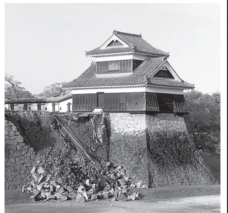
4月14日の前震で熊本城の本丸、二の丸などで被害。その後の本震や相次ぐ余震でダメージが拡大した (4月15日撮影)
