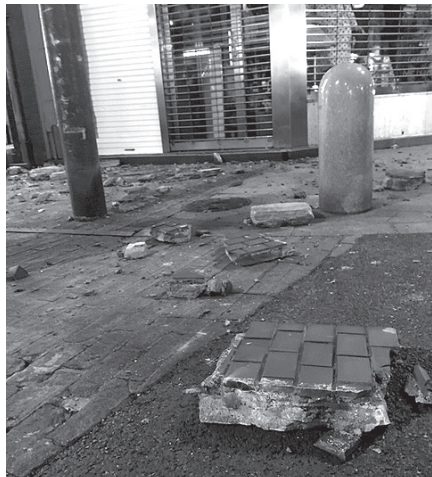
4月14日午後9時26分に発生した最大震度7を記録した前震直後の熊本市内の繁華街の様子。建物から外壁が落下して大きな破片が道路に散らばった。飲み会などで繁華街に居た人びとも騒然。通りは避難する人びとであふれた
