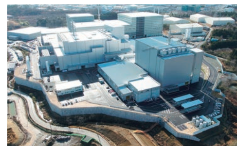
双葉町仮設焼却施設及び仮設灰処理施設
