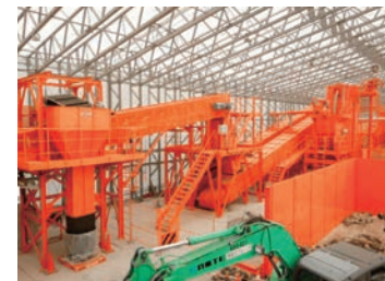
再生資材化施設
