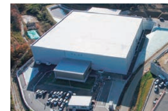
廃棄物貯蔵施設(双葉1工区)
