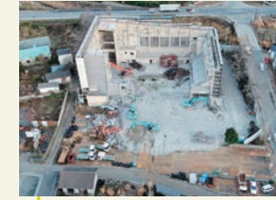
双葉町公民館・体育館の解体作業
