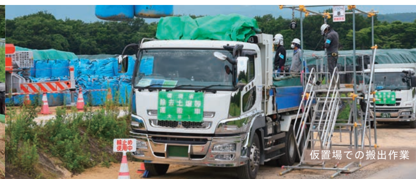
1 飯舘村長泥地区における再生利用実証事業
