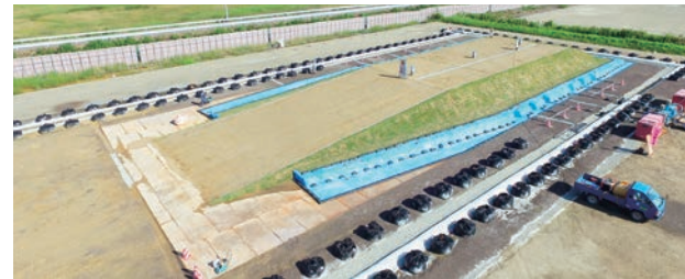
試験盛土の様子(2017年9月撮影)
