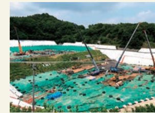
特定廃棄物埋立処分施設
