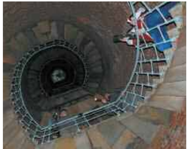
Winterkontrolle des Tiefbrunnens, Potsdam
