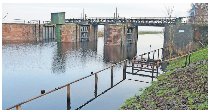
Die restaurierte Sielschleuse mit ihren vier Pfeilern und den drei Öffnungen mit den stählernen Stemmtpaaren.
