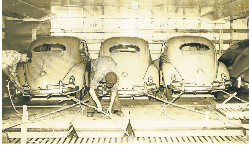
Auf den über Holzgrätingen liegenden Isolierdeckeln eines Kühlfrachtschiffs werden Autos als Stückgutladung geladet.
