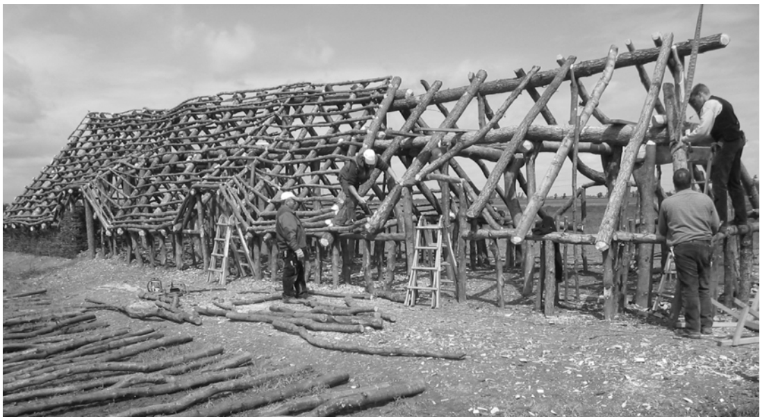
Abb. 2. Rodenkirchen-Hahnenknooper Mühle. Gerüst des dreischiffigen Wohnstallhauses im Nachbau. Foto: E. Strahl (NIHK).
