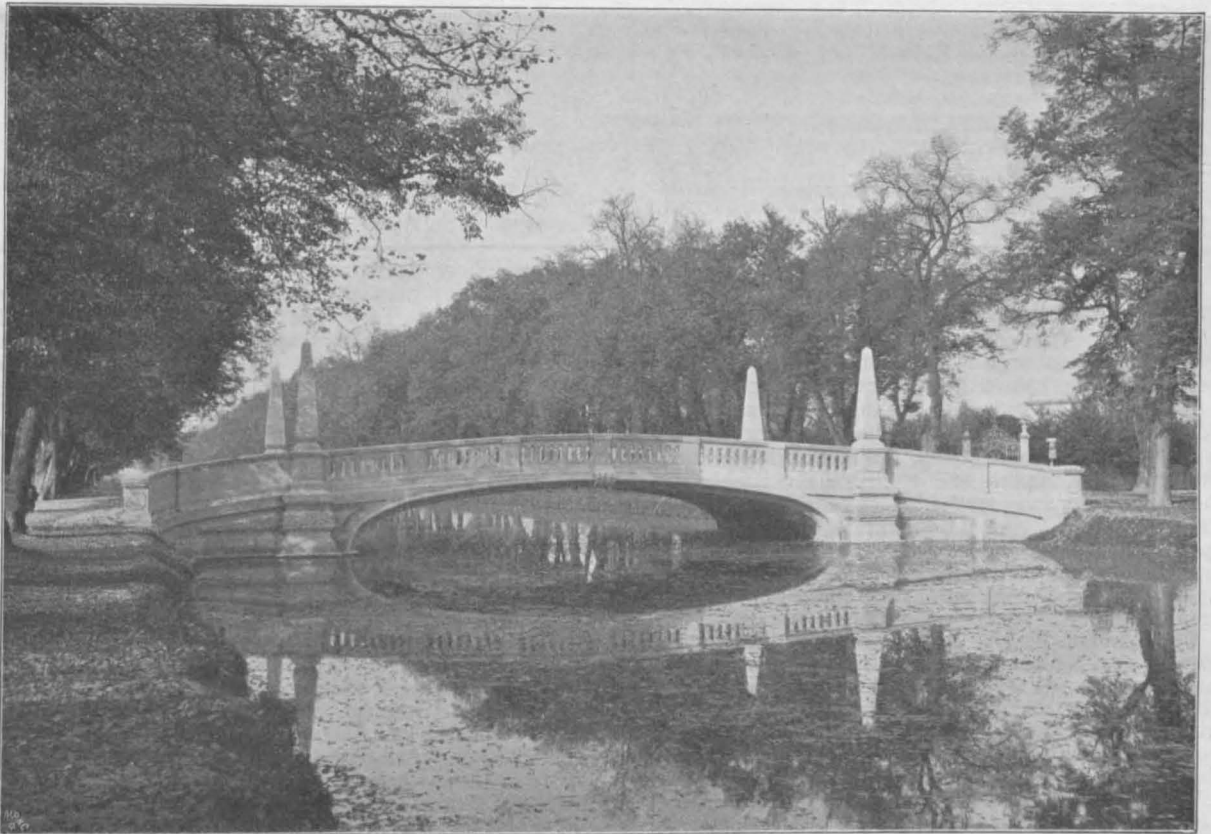
Abbildg. 9. Brücke über den Nymphenburger Kanal bei Gern-München (Ausführung: Wayss & Freytag.)
