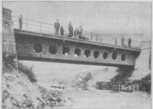
Abbildg. 8. Strassenbrücke bei Krapina. (Spw. 19,3 m.)
