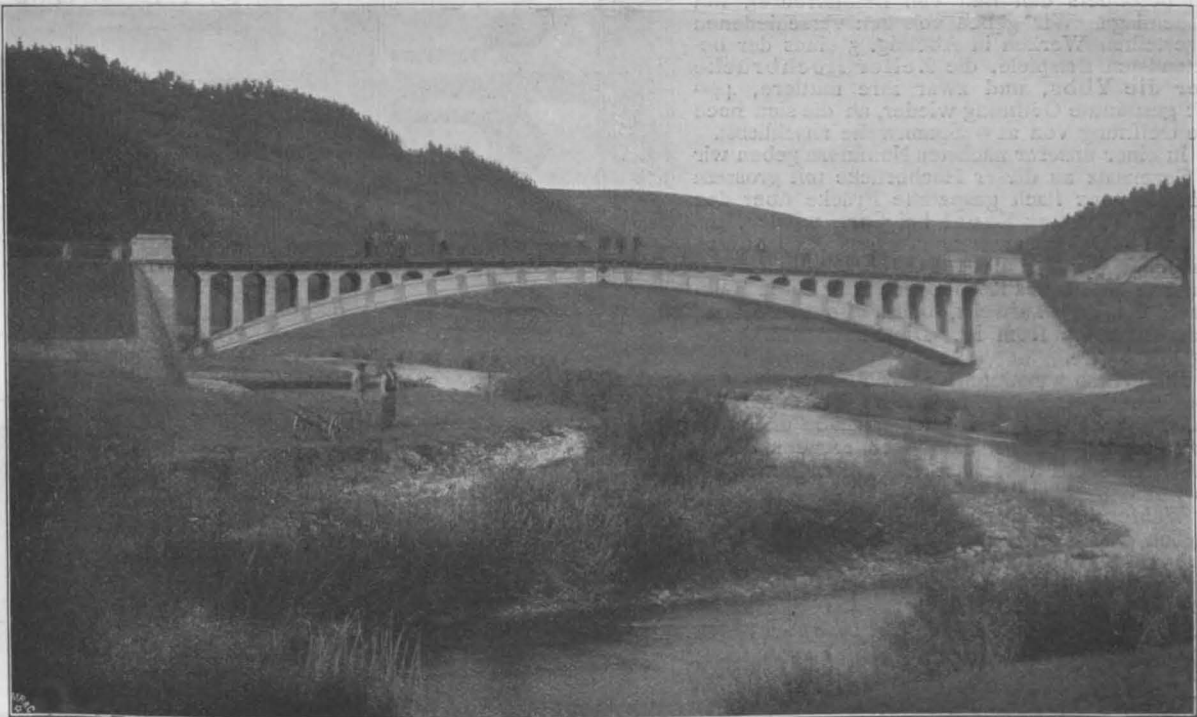
Abbildg. 6. Neckarbrücke bei Neckarhausen (50 m Spw.; Stampfbeton).
