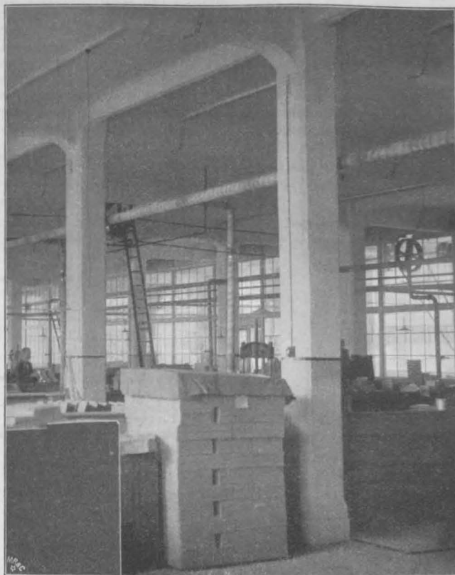
Abbildg. 19. Betoneisenbau der Fabrik von Ensslin & Laiblin in Reutlingen.
