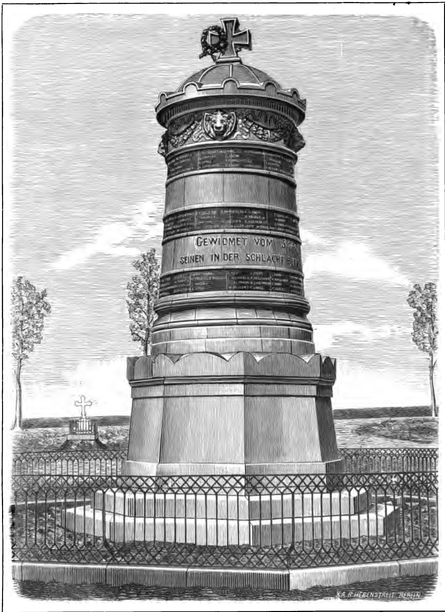
Denkmal des Regiments auf dem Schlachtfelde von Mionville.
