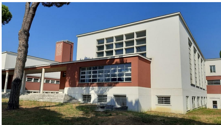
Fig. 11 Vista dal campo sportivo della palestra dopo il restauro (anno 2017)
