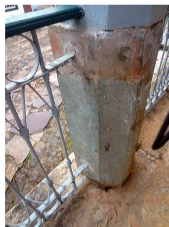
Figura 9. Detalhe da fixação do gradil da varanda em uma das colunas. Fonte: Acervo dos autores, 2022.
