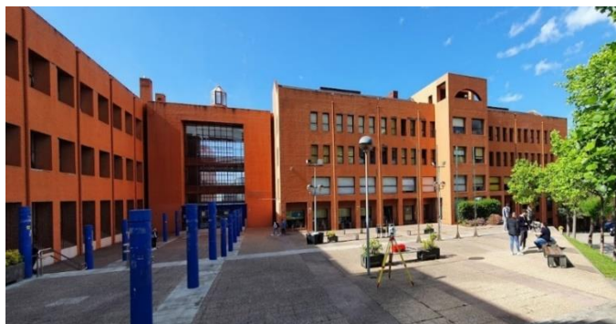
Figura 2. Vista de la fachada sur del edificio Interfacultativo de la UC.
