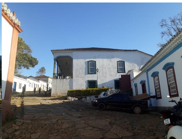
Figura 3. Vista atual da edificação voltada para a Rua Jogo da Bola. Fonte: Acervo dos autores, 2022.
