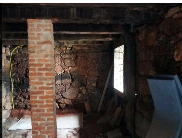
Figura 7. Vista do porão com destaque para o reforço estrutural no porão. Fonte: Acervo dos autores, 2022.
