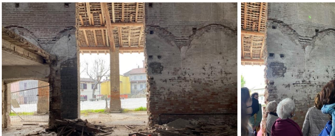
Figura 1. A sinistra il solaio che suddivide la stalla (al piano terra) dal fienile (al piano primo); a destra Calendaschesi in visita invitati a leggere la stratigrafia muraria (foto di Michela M. Grisoni).
