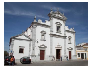
Figura 33. Fachada principal da Catedral de Beja, depois das obras.
