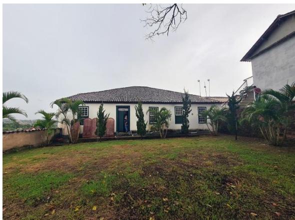
Figura 4. Vista atual da edificação voltada para os fundos do terreno. Fonte: Acervo dos autores, 2022.
