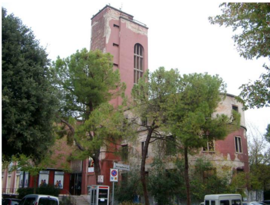
Fig. 4 Vista del prospetto su viale della Libertà (ex viale Mussolini) (anno 2001)
