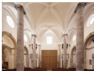
Figura 31. Nave central e guardavento da Catedral de Beja, depois das obras.
