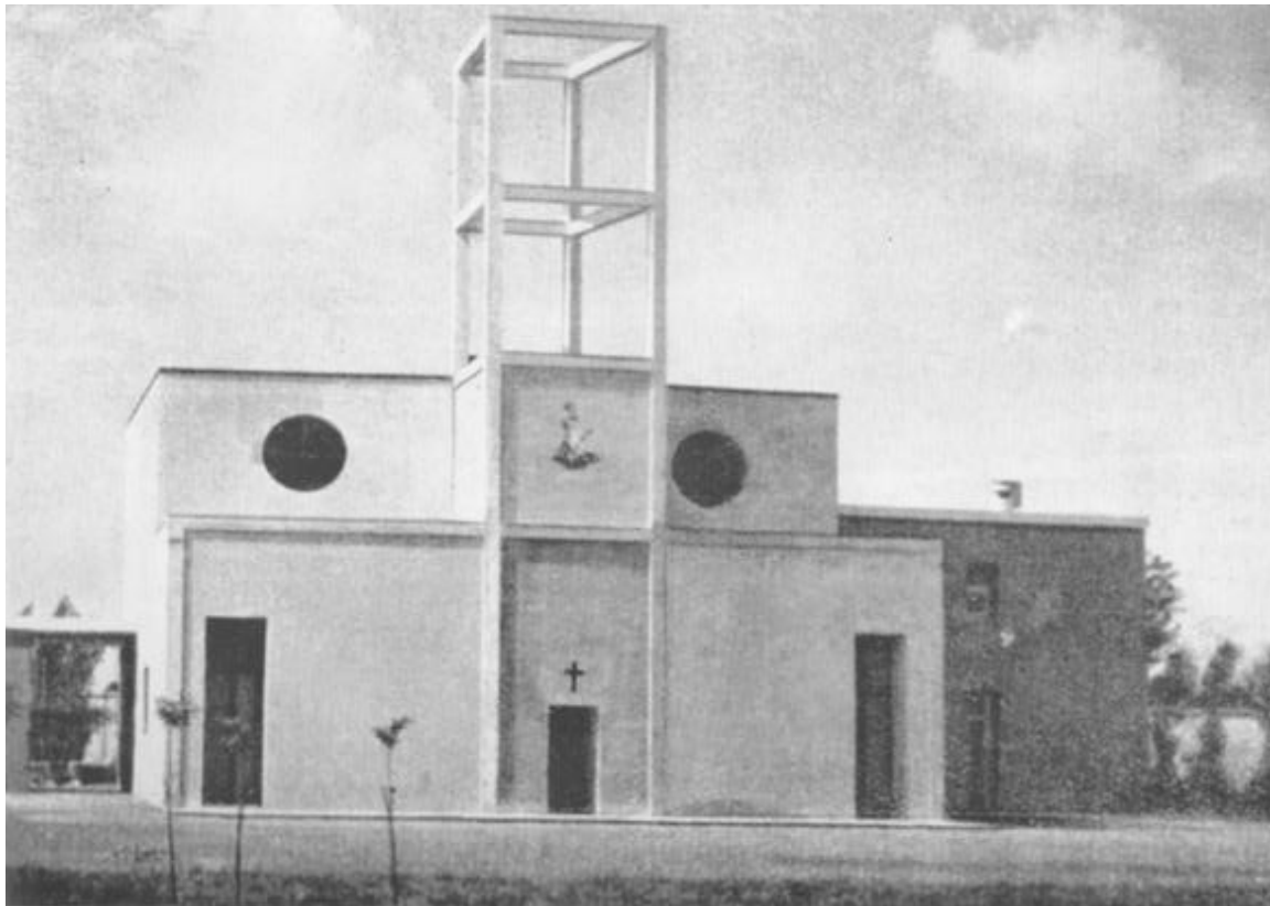
Figura 4. L'esterno e la struttura a traliccio del campanile (da "Alessandria", 1938).
