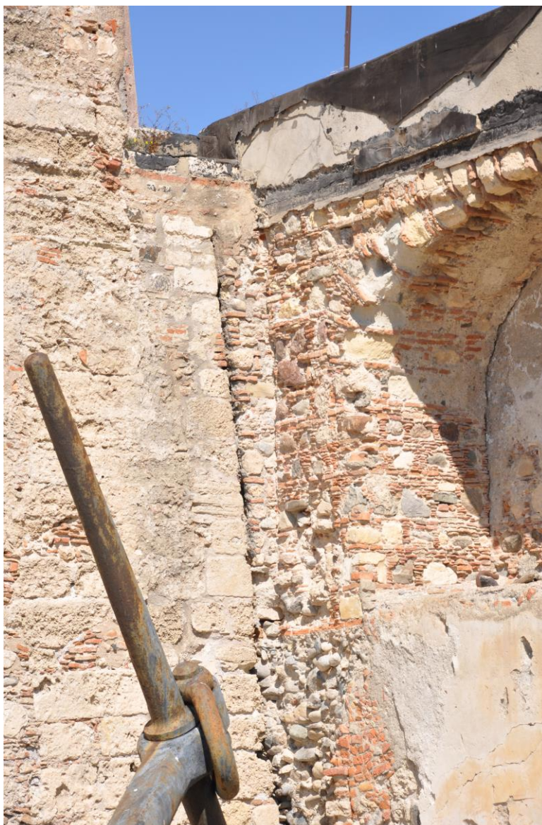
Fig. 13. Dettaglio dell'appoggio della muratura nord del forte del SS. Salvatore sul cantonale del muro nord-est di Forte Campana
