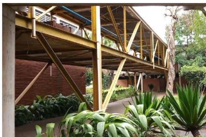
Figura 5. Vista lateral da passarela. Fonte: De autoria própria.
