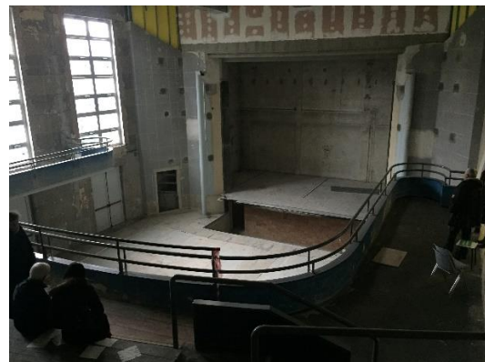
Fig. 13 Cinema dopo la rimozione degli arredi (anno 2019)
