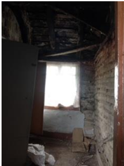
c) Tabique wall
