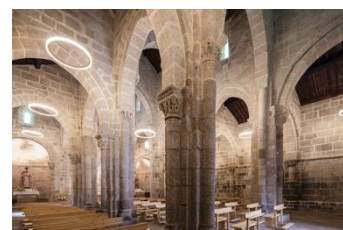
Figura 27. interior da Igreja do Mosteiro de Travanca, depois das obras.
