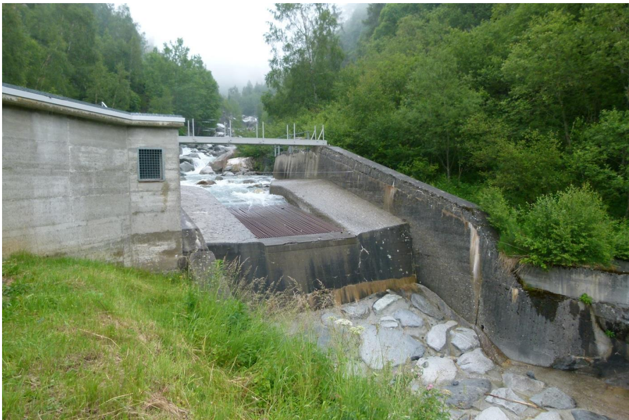
Abbildung 1 Tirolerwehr am Rein da Plattas.
