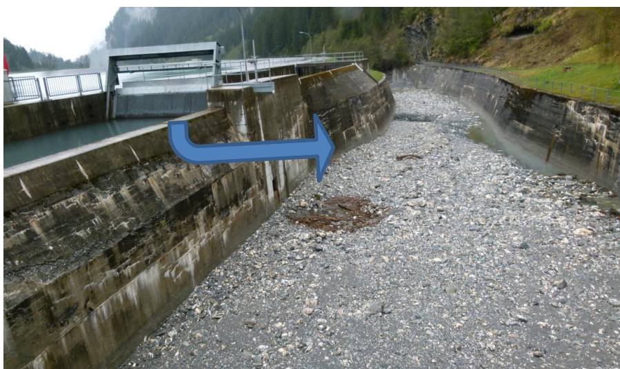
Abbildung 1 Situation für mögl. Bypass (blauer Pfeil), Abfangen der Fische vor Feinrechen, um sie via Rutsche ins Gewässer zurückzubringen.
