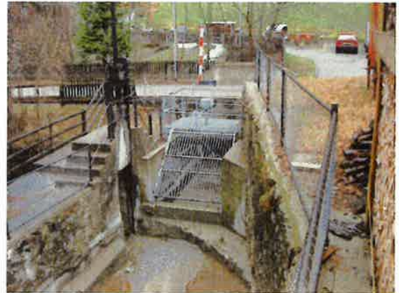
Bild 2 Durchlauf Plessur in Mühlbach
