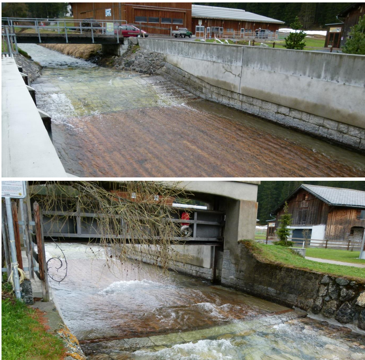
Abbildung 1 Oben: nicht passierbare Rampe oberhalb des Wehrs; unten: Geöffnetes Wehr.
