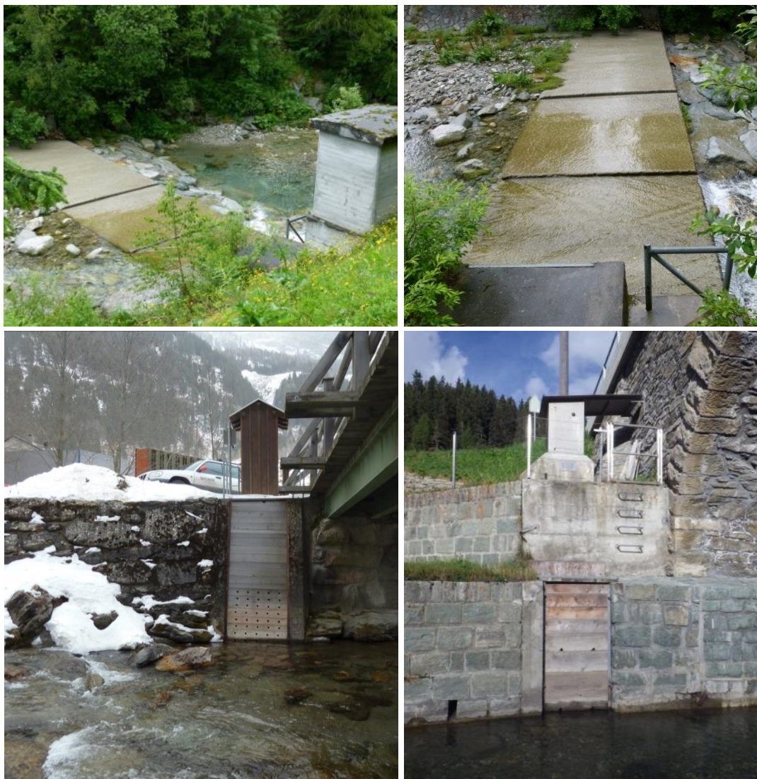
Abbildung 1 Oben: Messschwelle unterhalb der Fassung Sedrun; unten: zwei Beispiele von analogen Messstellen mit Pegeldrucksonde ohne vorgelagerte Schwelle (unten links: Messstelle Permut im Poschiavino der Repower AG; unten rechts: Messstelle Campsut im Averser Rhein vom Amt für Natur und Umwelt GR).
