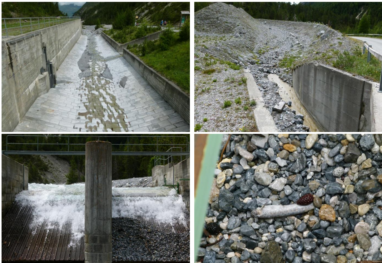
Abbildung 1 Oben links: gepflasterter Kanal unterhalb des Wehrs, oben rechts: Rufenbach, welcher mit der Fischtreppe zu queren wäre, unten links: Kiesansammlung auf dem Tirolerwehr, unten rechts: Fisch in den Kiesablagerungen auf dem Tirolerwehr.
