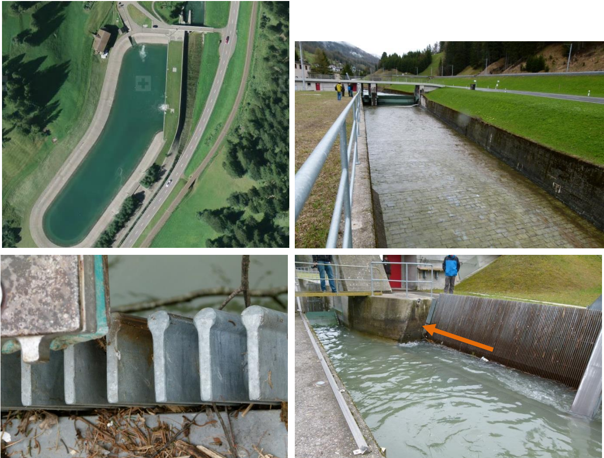
Abbildung 1 Oben links: Situation Ausgleichsbecken, Wehr, Landwasser und Kantonsstrasse; rechts: Kanal mit Betonmauern und Pflasterung der Sohle; unten links: Profil Feinrechen; rechts: Lage des Rechens vor dem Einlaufbauwerk mit möglicher Stelle für den Durchgang eines Bypasses (oranger Pfeil).
