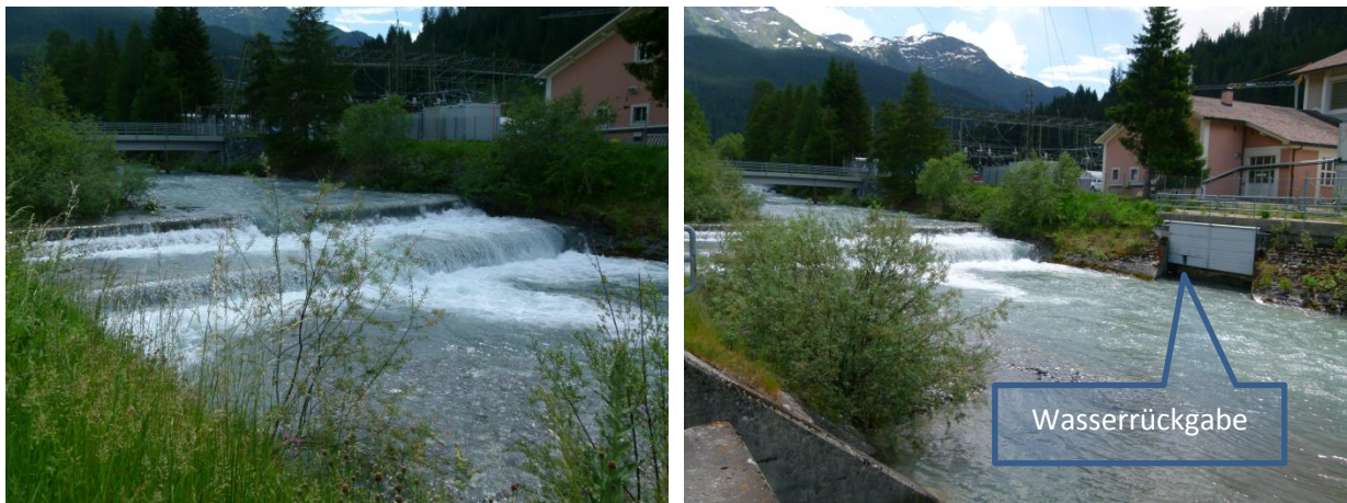
Abbildung 1 Bild Links: die zwei unmittelbar hintereinander liegenden Schwellen, rechts: die Wasserrückgabe Tinizong.
