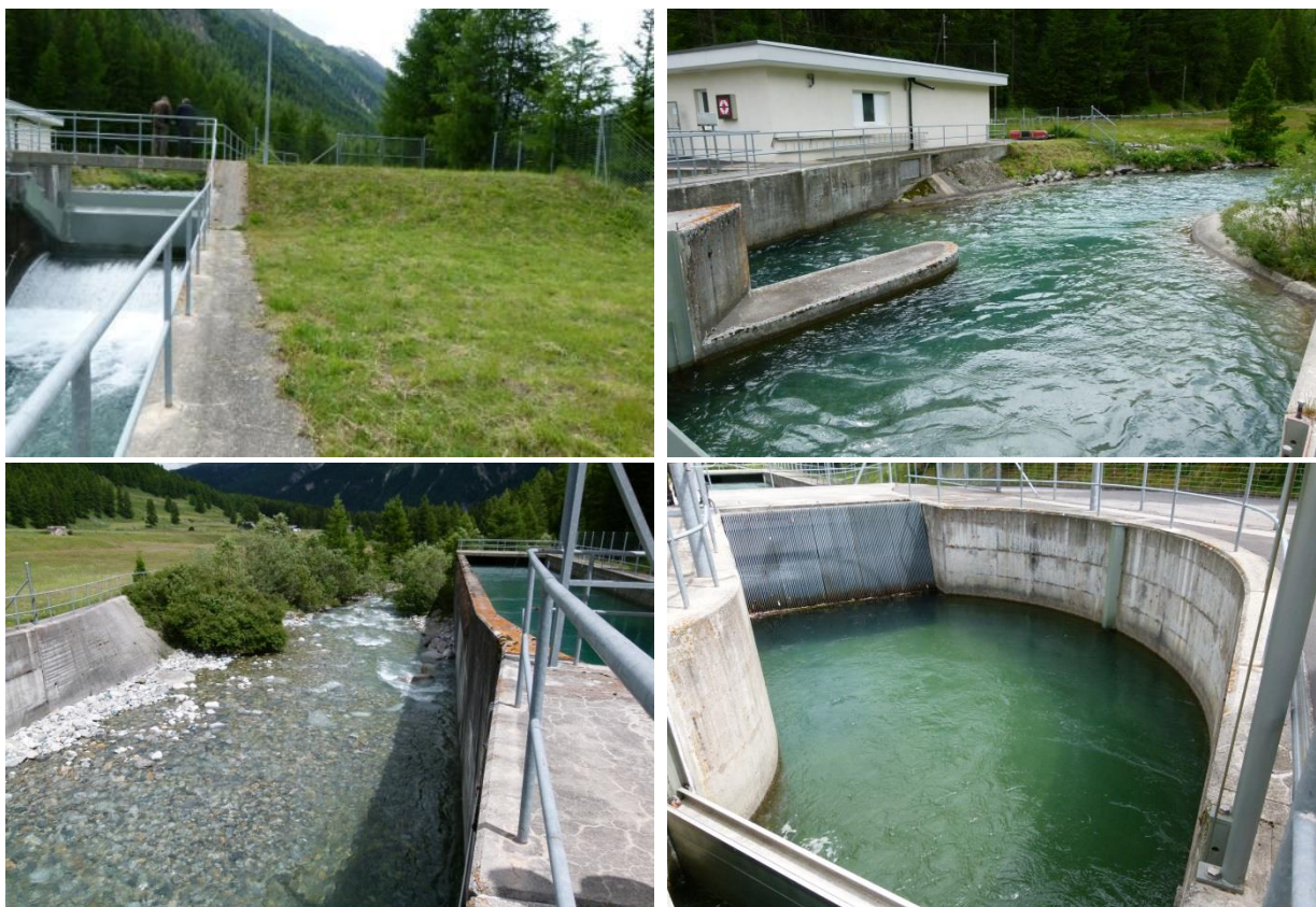
Abbildung 1 Oben links: Platzverhältnisse linksseitig des Wehrs, oben rechts: geschützter Bereich für den Ausstieg aus dem Fischpass; unten links: Situation Entsander und Unterwasser (im Bild mit Überlauf, ansonsten hier Restwasser Null); unten rechts: Feinrechen vor Einlaufbauwerk, wo die Fische abgeholt und via Rutsche ins Unterwasser gebracht werden könnten.
