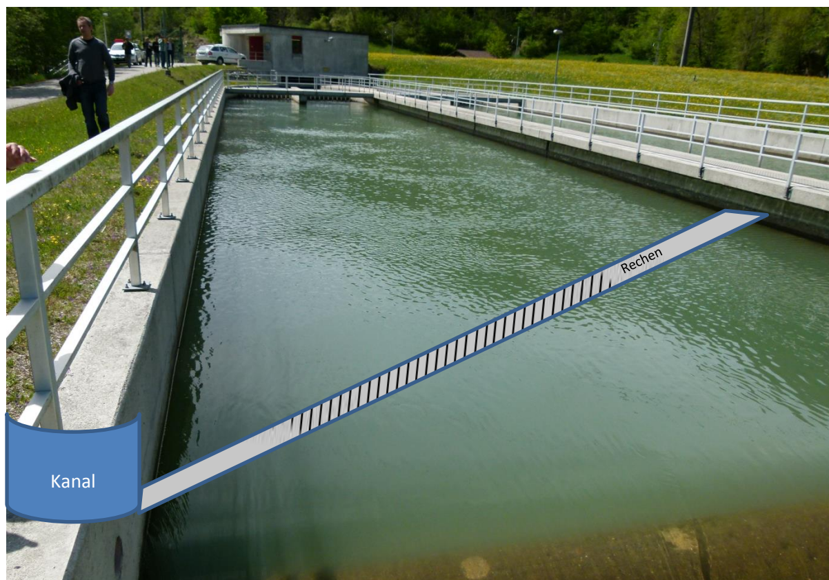
Abbildung 1 Möglicher Feinrechen am Ende des Entsanders leitet die Fische mittels Kanal in den Vorderrhein zurück.
