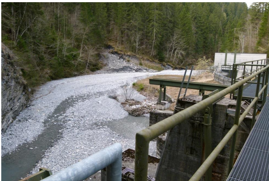
Abbildung 1 Situation Wehr Lünen.
