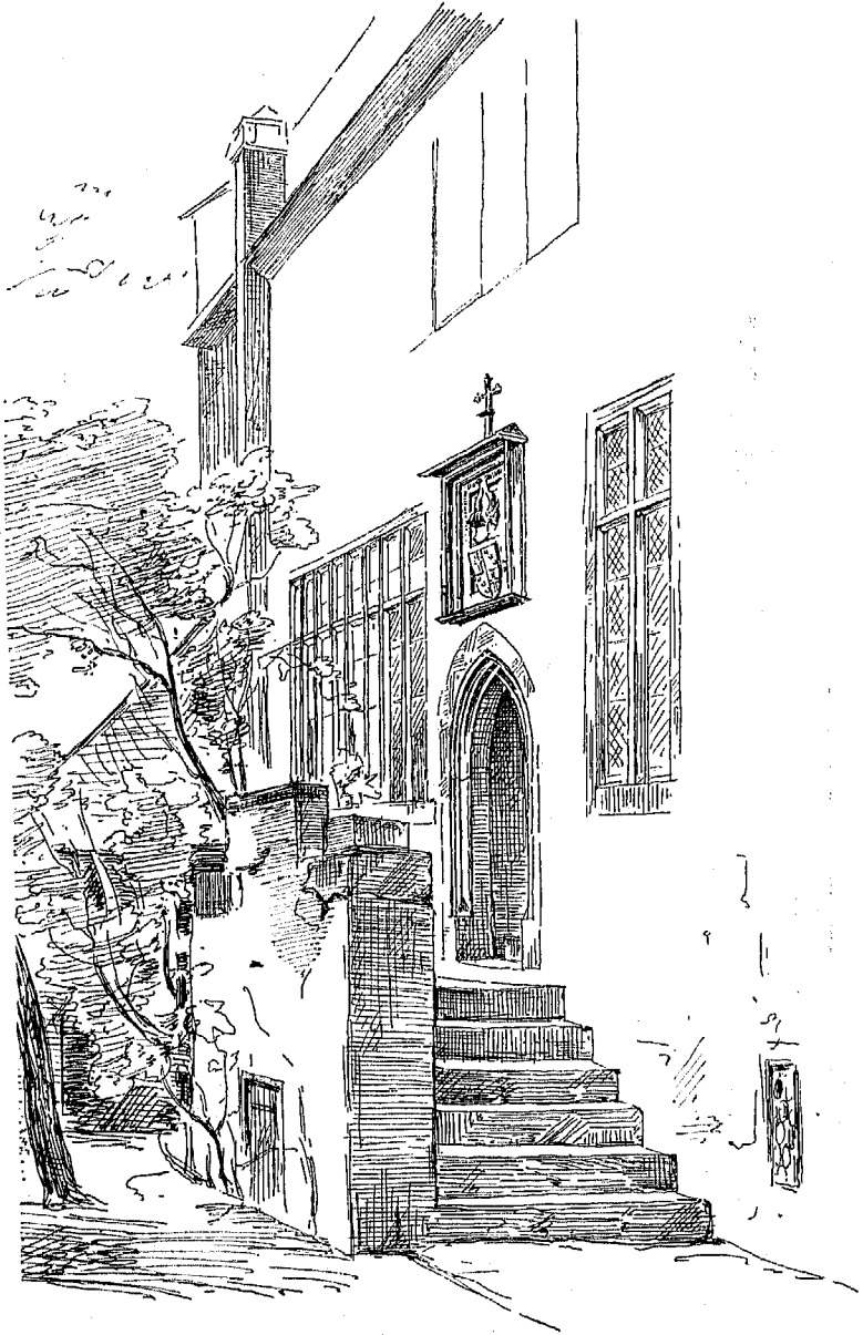
Fig. 319. Johanniter-Hof; Eingang mit Wappenstein.
