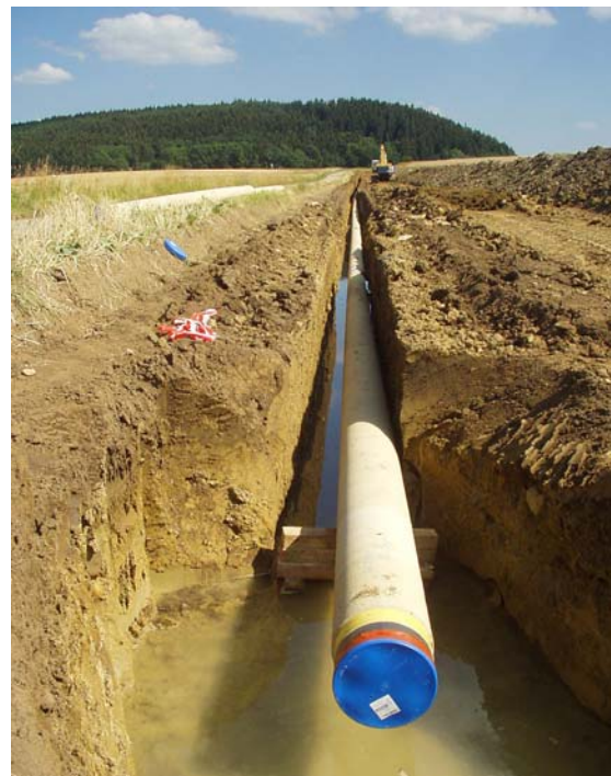
Abbildung 10: Bodeninanspruchnahme beim Bau einer Gasleitung (Schwarzwald-Baar-Kreis)
