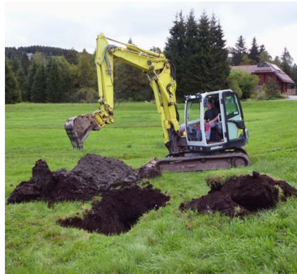
Abbildung 6: Verlegung einer Leitungstrasse in einem Hochmoor bei Breitnau (Landkreis Breisgau- Hochschwarzwald)
