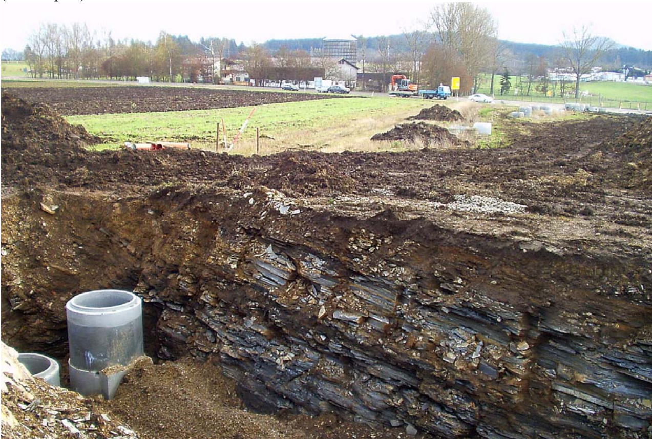
Abbildung 14: Erschließung eines Neubaugebietes mit Eingriff in den flachgründigen Boden und Untergrund bei Spaichingen (Kreis Tuttlingen)
