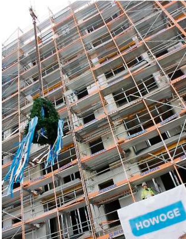
Für das Wohnquartier wurde der Richtkranz aufgezogen. Foto: Bernd Wähler
