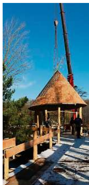
Für den Giraffenpfad konnte jetzt das Richtfest gefeiert werden. Dafür wurden schon mal probeweise die beiden Dächer der Aussichtsplattformen auf den Dachstuhl aufgesetzt. Foto: Tierpark Berlin
