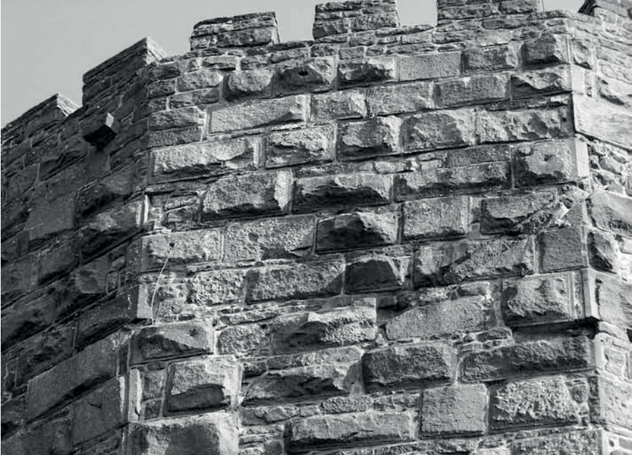
Mischmauerwerk der Schildmauer auf Burg Dilsberg aus dem 14. Jahrhundert. Die wiederverwendeten Buckelquader haben die typische Form des 12. Jahrhunderts.
