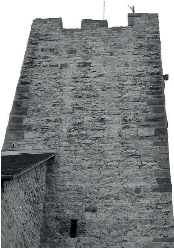
Burg Lauffen – der nachträglich auf den alten Anbau gesetzte Bergfried mit Eckquadern aus Tuff und Sandstein, letztere zum Teil als Buckelquader ausgebildet.
