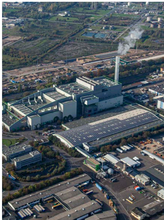
Müllverbrennungsanlage, Quelle: AVG Köln
