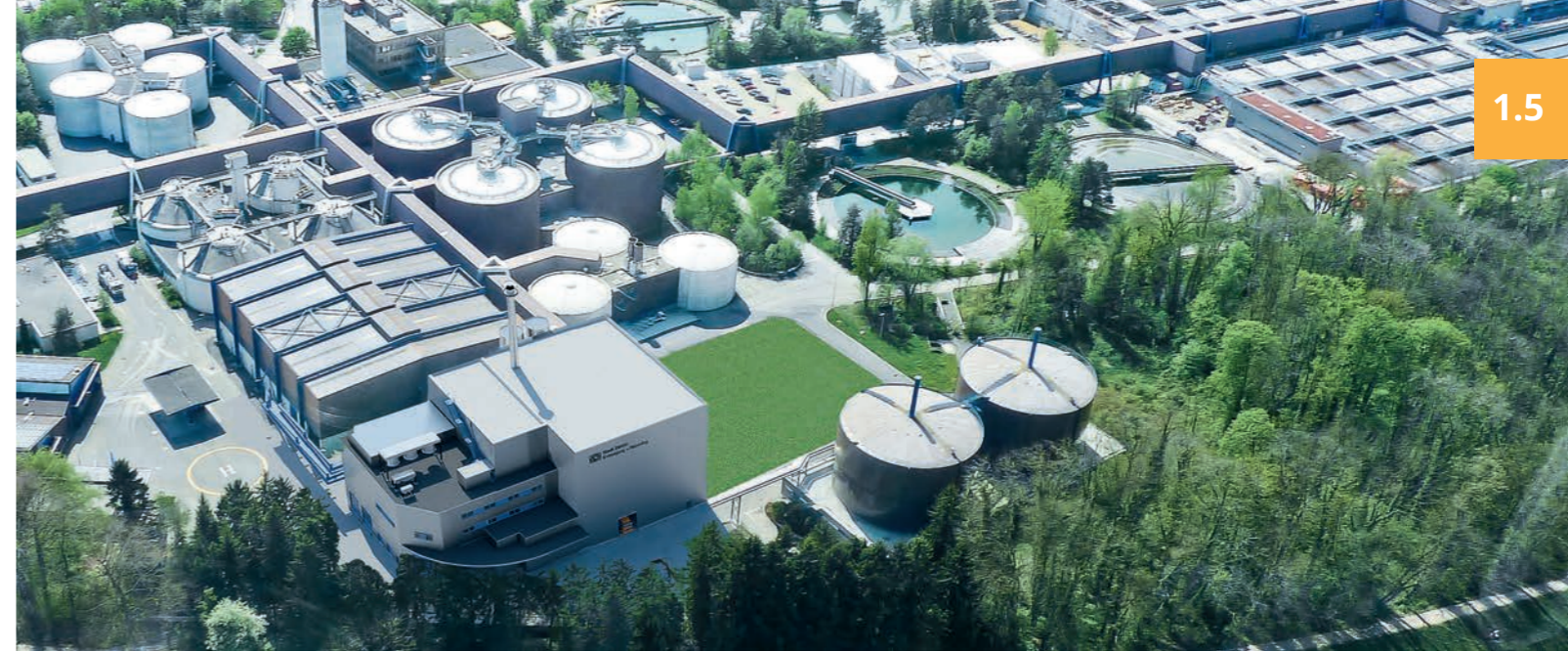
Monoklärschlammverbrennungsanlage in der Schweiz, Quelle: TBF
