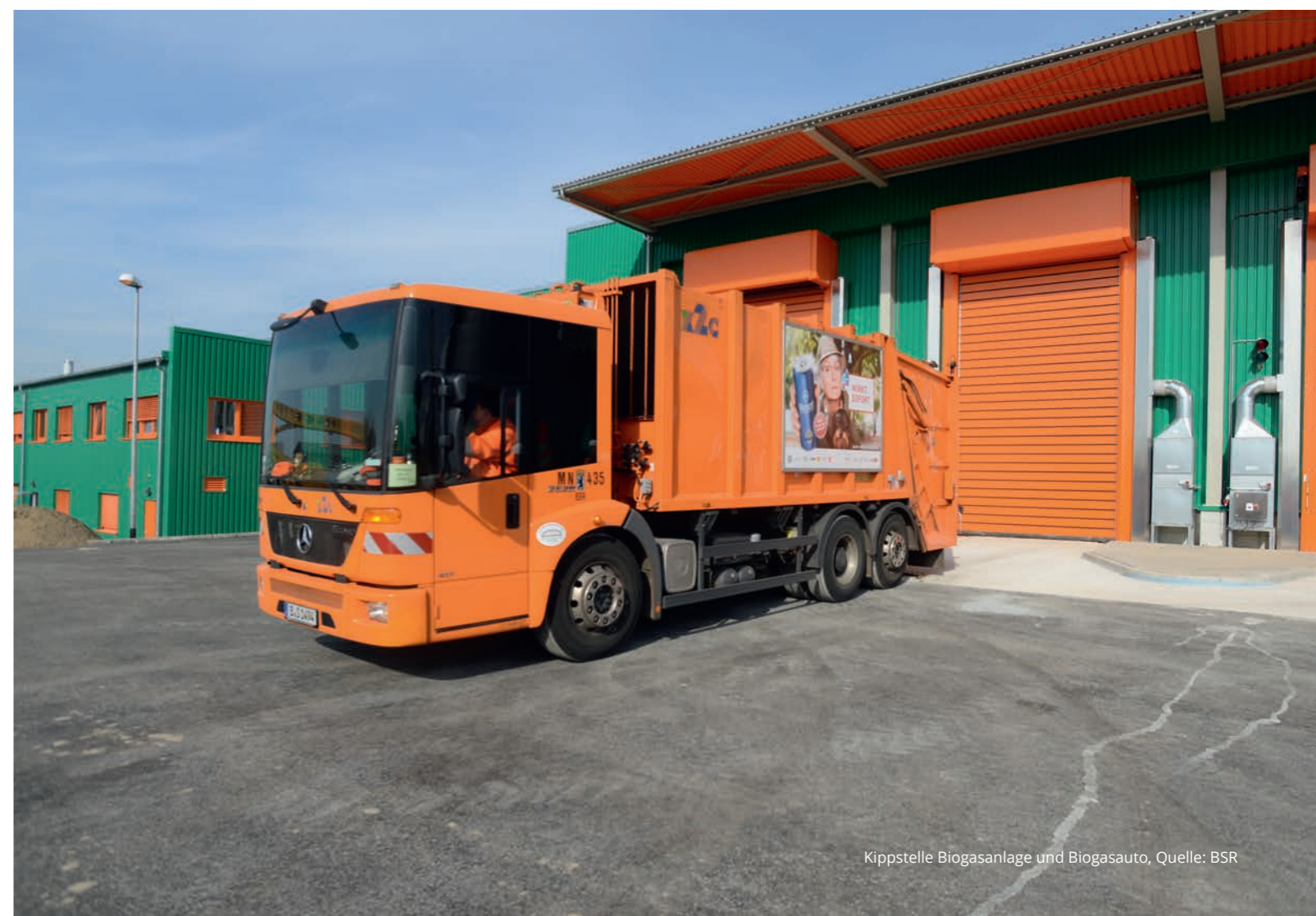
Biogasanlage, Quelle: BSR
