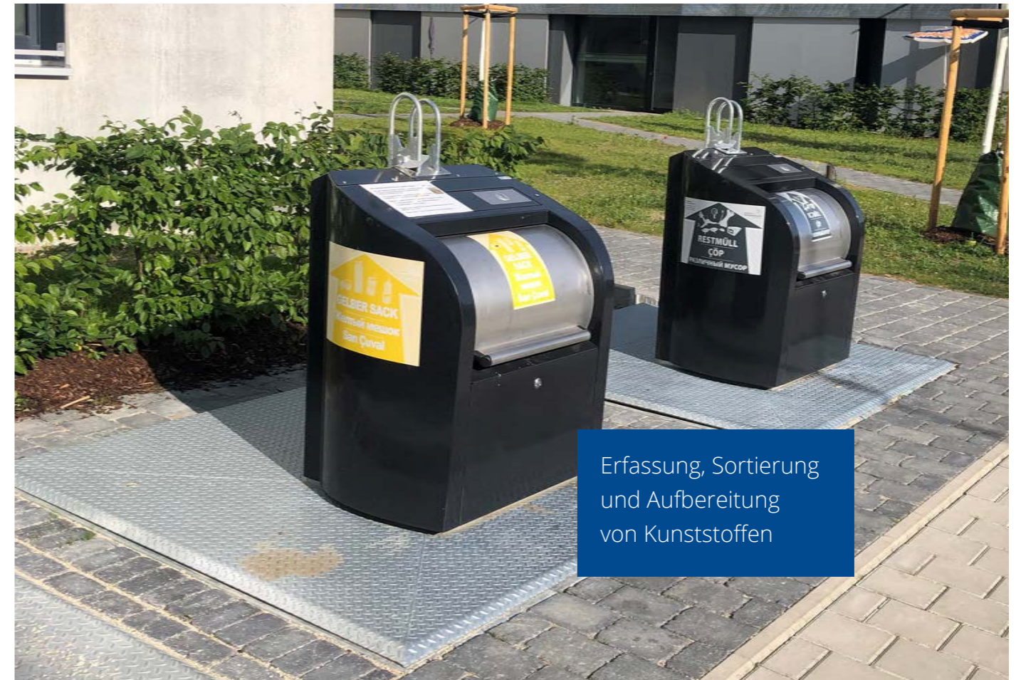
Sammlung Gelber Sack mit Unterflurpresscontainer, Quelle: SIDCON
