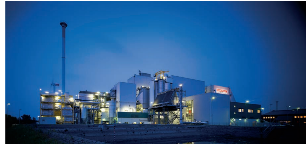
Sonderabfallverbrennungsanlage: Durch Behandlung Zerstörung von gefährlichen Substanzen, Quelle: REMONDIS
