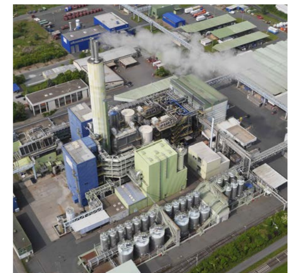
Sonderabfallverbrennungsanlage mit Lagertanks, Quelle: HIM
