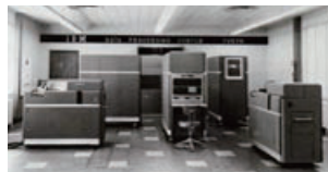
初のIBM650を麹町本社に設置し、計算センターを開設。パンチ・カード・システムからコンピューター時代へ [1958年]
