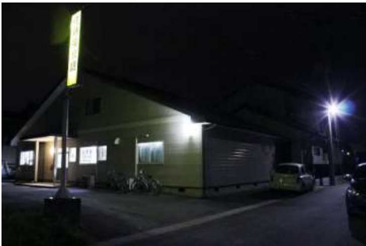
② 設置されたLED防犯灯（2013年7月撮影）
