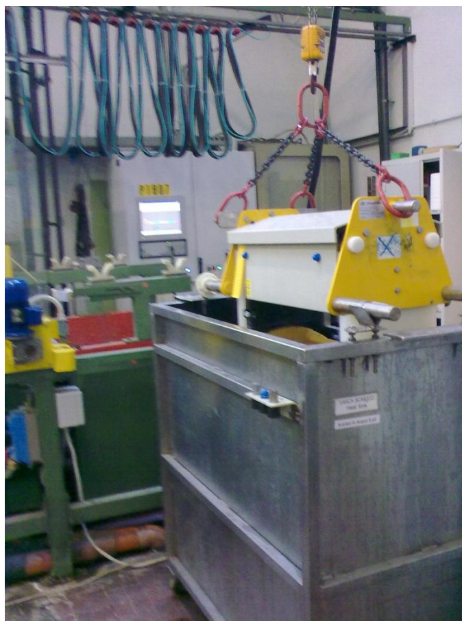
Figura 1.5 Vasca finale per lo scarico degli heatsink dai rotabarili. In secondo piano si nota il display del PLC di controllo.
