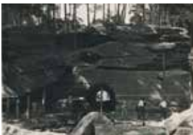
Tiergehege wurden in den Sandsteinfels eingefügt
