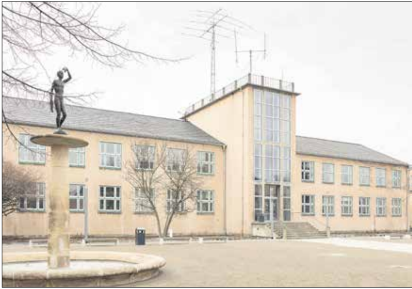
Der Barkhausen-Bau von der Helmholtzstraße aus gesehen.
