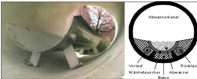
Abb. 19: Rinnenwärmetauscher für Kanäle mit Kreisprofil Der WT wird als Trockenwetterrinne inkl. Vor- und Rücklaufleitungen eingegossen. Einsetzbar ab Kanaldurchmessern von 1 m. Vorteil: Hydraulisch günstig. Nachteil: Relativ grosser Querschnittsverlust. (eingesetzt in Zürich-Wipkingen)
