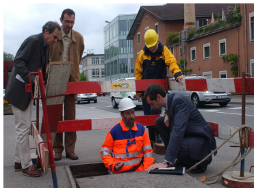
Abb. 6: Einstieg zum Kanal-WT bei der IWC in Schaffhausen
