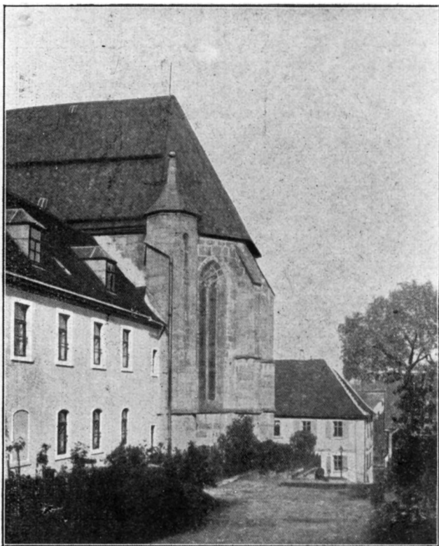
Ib. Die Kirche von Osten links das ehemalige Kloster, jetzt Blödenanstalt rechts das Pfarrhaus.
