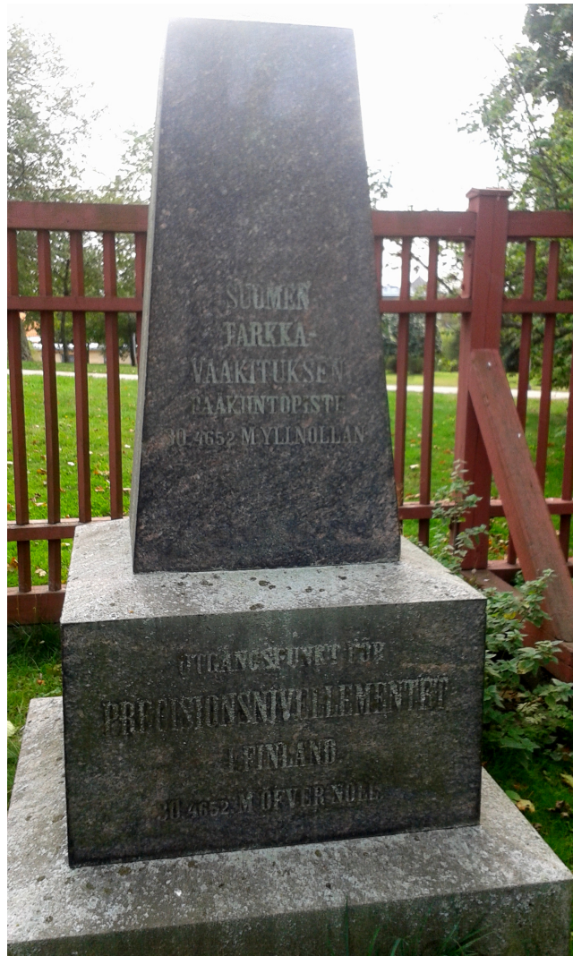
FIGURE 7.2. Height reference benchmark in the garden of the Helsinki astronomical observatory in Kaivopuisto, Kääriäinen (1966) . Text:
