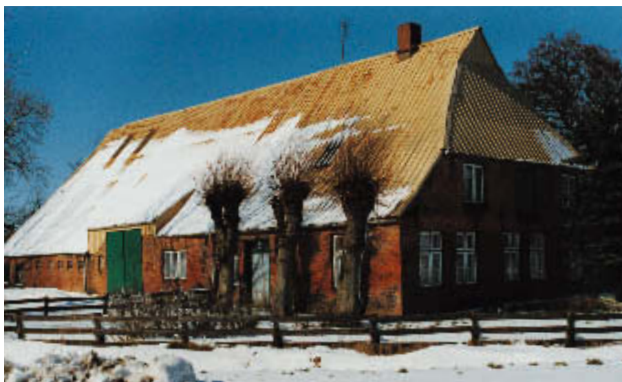
Fig. 4.54: „Dwerhaus“ farmhouse with cross-passage, Epen- wörden bei Meldorf vacant at time
