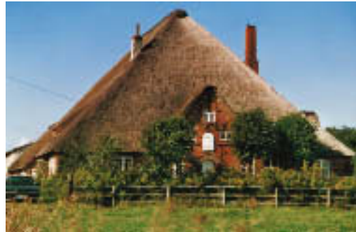
Fig. 4.50: „Haubarg Matthießen“ 1760 Barg-construction, 4 posts, Wittendün St. Peter utilization: agriculture
