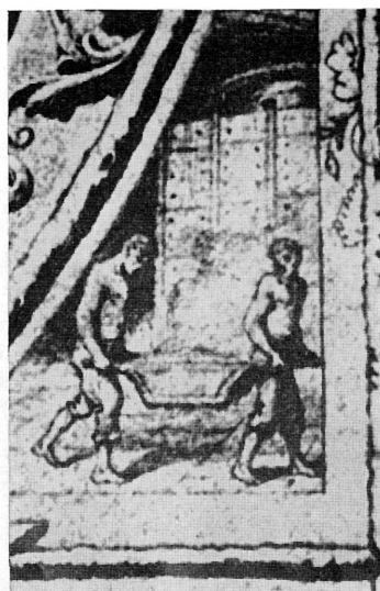
図10 19世紀の硫酸工場のパイライト焼鉱の搬出 17)
