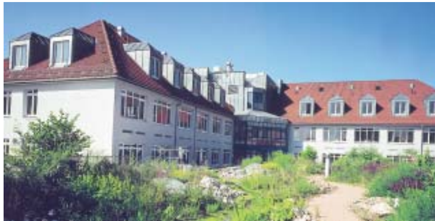
Einzug in das neue Institutsgebäude in München im Oktober 1993
