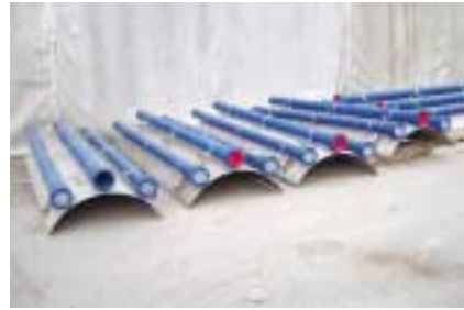
Rinnenwärmetauscher vor dem Einbau in einen Kanal.
