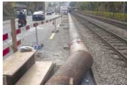
Umleitung des Abwassers während der Bauzeit.
