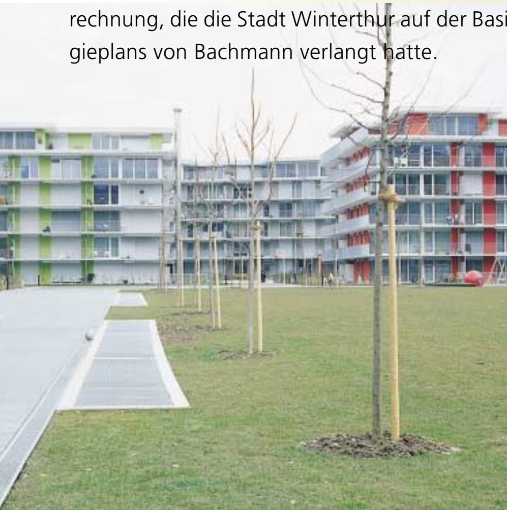
400 Wohnungen der Siedlung Wässerwiesen in Winterthur werden mit Wärme aus Abwasser beheizt. Foto L. Blazevic, tec21
