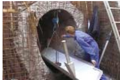
Einbringen des Wärmetauschers in einen bestehenden Kanal.
