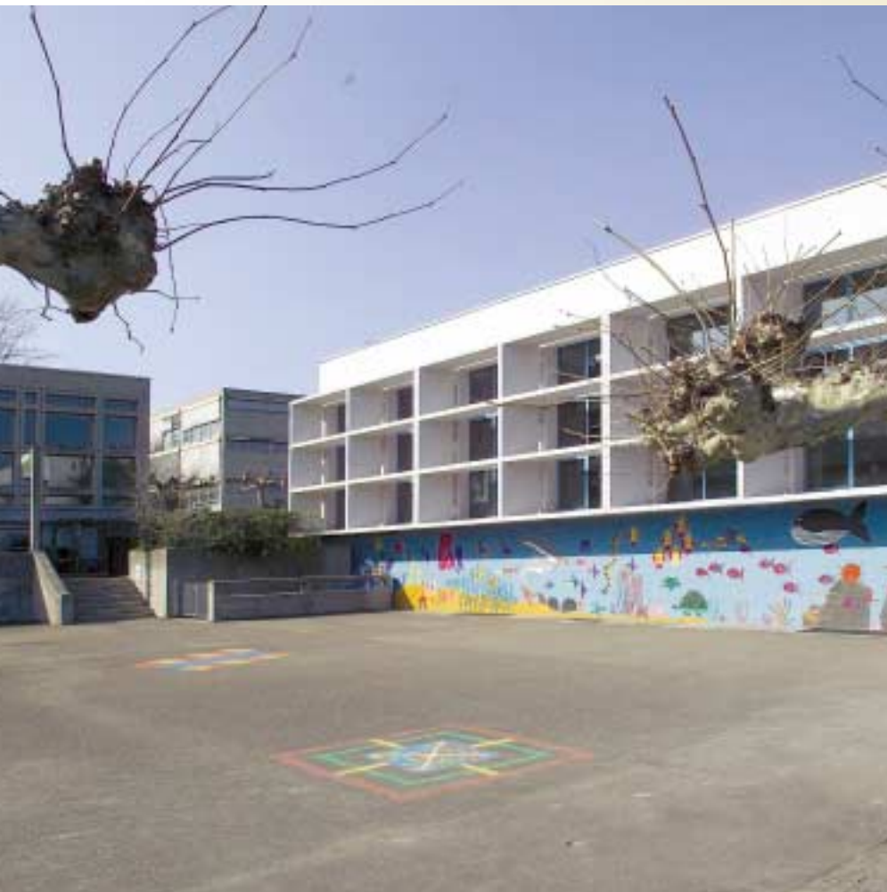
Anschauungsunterricht für kommende Generationen: Das Schulhaus Spiegelfeld in Binningen wird mit Abwasserwärme geheizt.
