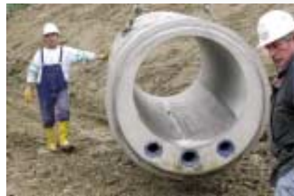
Vorgefertigtes Kanalelement mit eingebautem Wärmetauscher.
