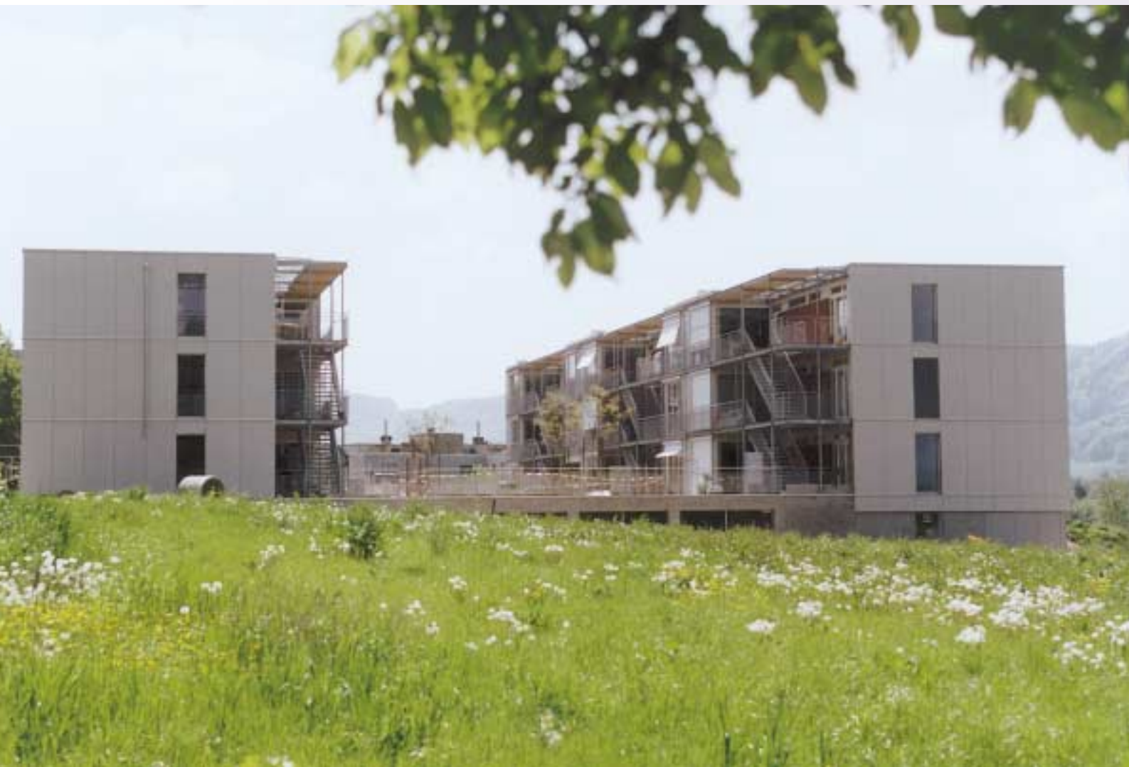
In Zürich-Wollishofen wird eine Siedlung mit über 200 Wohnungen mit Wärme aus dem Netz der Wasserversorgung geheizt. Foto ewz
