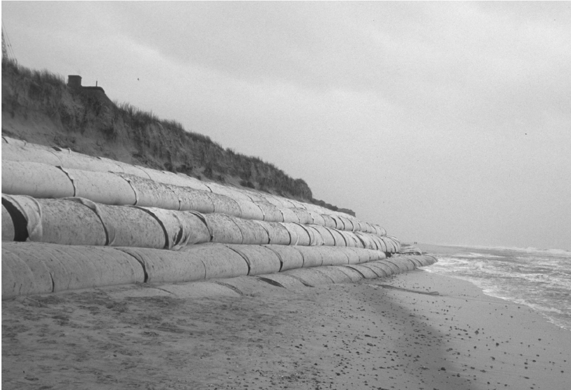
Abb. 26: Geotextiles Deckwerk vor dem Haus Kliffende / Kampen (Zustand: Feb. 2000)
