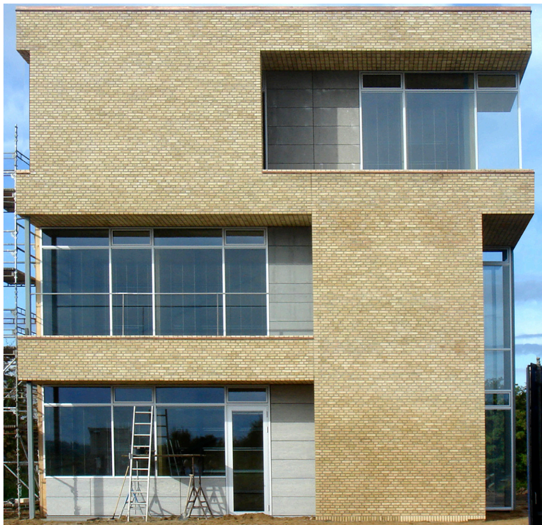
Mock-up af husets fulde højde / Mock-up Fassadenausschnitt in voller Höhe
