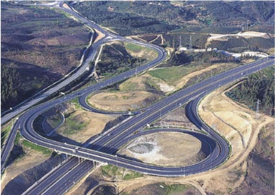
□ SCUTVIAS – Auto-Estrada da Beira Interior (A23) Beira Interior Motorway (A23)
