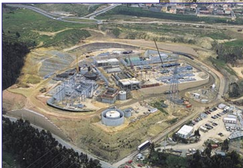
VALORSUL – Central de Valorização Orgânica, Amadora – Waste Water Plant for urban organic solid waste
