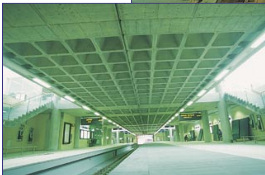
METROPOLITANO DE LISBOA – Estação de Odivelas – Odivelas Underground Station
