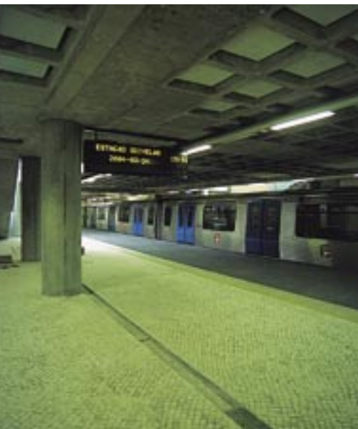
METROPOLITANO DE LISBOA – Estação de Odivelas – Odivelas Underground Station
