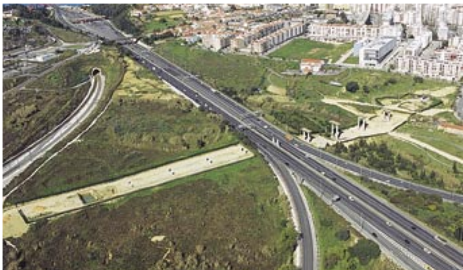
METROLIGEIRO – Metro Sul do Tejo, Almada (Viaduto sobre a A2) – Construction of the Light Tram Network
