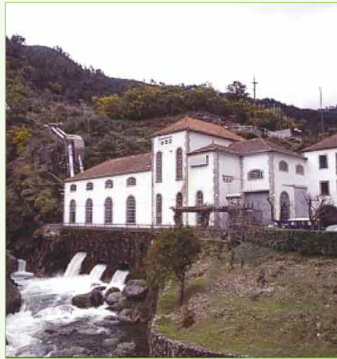
Central Hidroeléctrica de Ponte de Jugais
