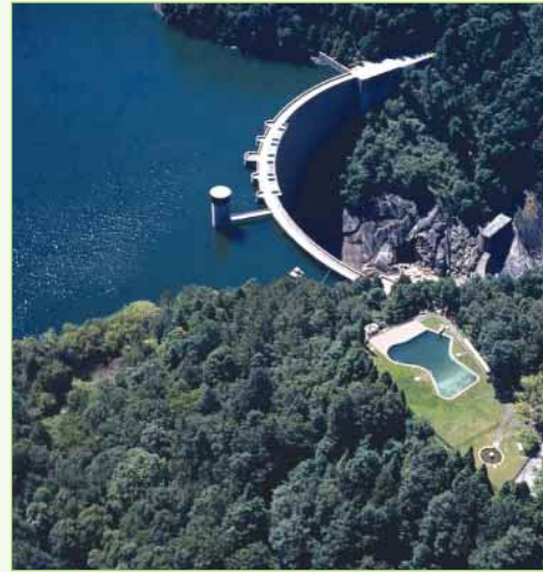
Central Hidroelétrica de Caniçada
