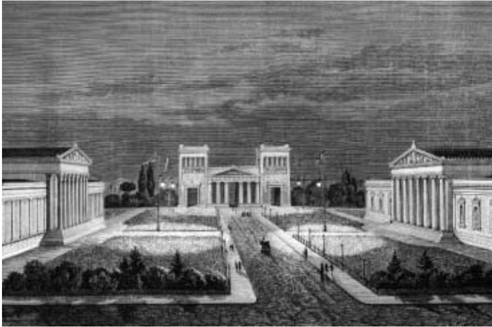
Abb. 18: Während der Internationalen Elektrizitätsausstellung in München im Jahr 1882 wurde der Königsplatz mit 4 Bogenlampen erbellt.
