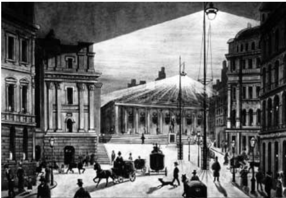
Abb. 19: Beleuchtung des Mansion-Platzes in London durch Siemens'sche Bogenlampen, um 1880. Wie deutlich zu sehen ist, wurden die Bogenlampen aufgrund ihrer großen Lichtstärke weit höher und in größeren Abständen gehängt als die traditionelle Straßenbeleuchtung.
