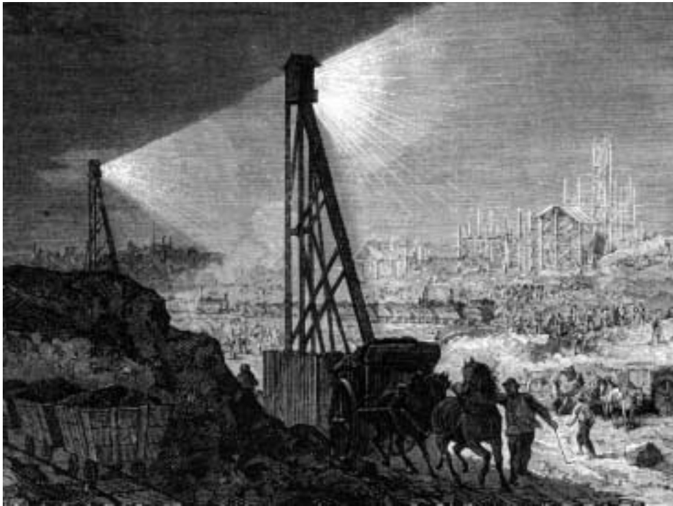
Abb. 6: Erste Verwendung des Bogenlichts bei nächtlichen Bauarbeiten in Paris im Jahr 1854.
