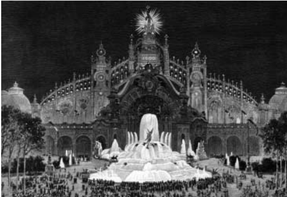
Abb. 26: Der Elektrizitätspalast auf der Pariser Weltausstellung im Jahr 1900 mit strahlend erleuchteten Springbrunnen.
