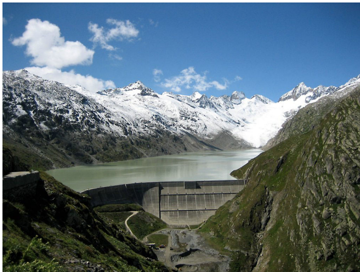
The Grimsel Oberaarsee Dam
