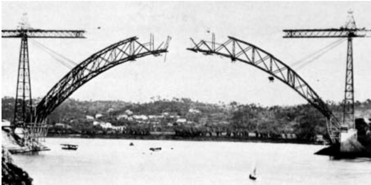
Fig. 3.7: Pont sur le Douro, under construction. Gustave Eiffel, 1877, Porto, Portugal. (Loyrette)
