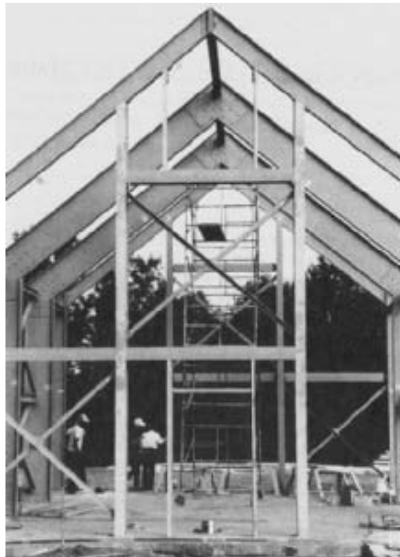
Fig. 6.25: Pultruded FRP portal frame, USA. Strongwell. (Cosenza et al.)
