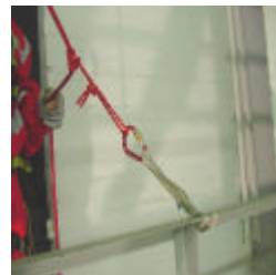
Bild 3 Prusik auf Brems- seite am Festpunkt
