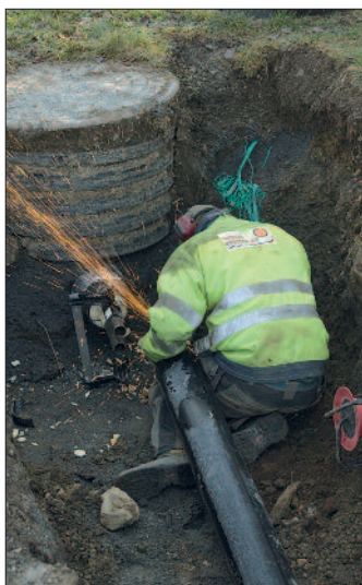
Svetsaren Urban Jonsson hör till en eftertraktad yrkesgrupp just nu. Inte minst i Östersund där nya byggprojekt skapar stor efterfrågan på fjärrvärme.
