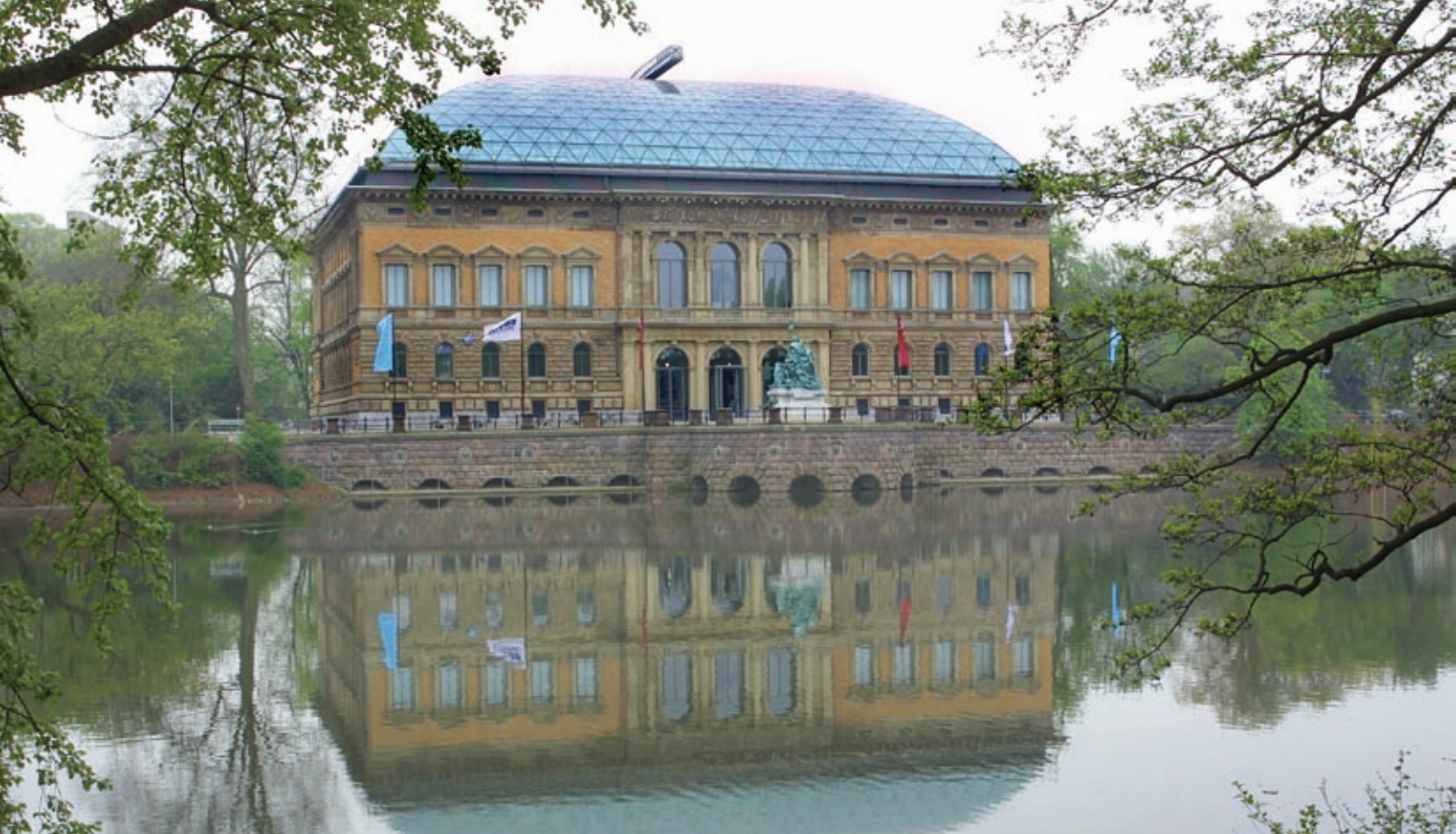
Kunstsammlung K 21 – Ständehaus nach dem Umbau
