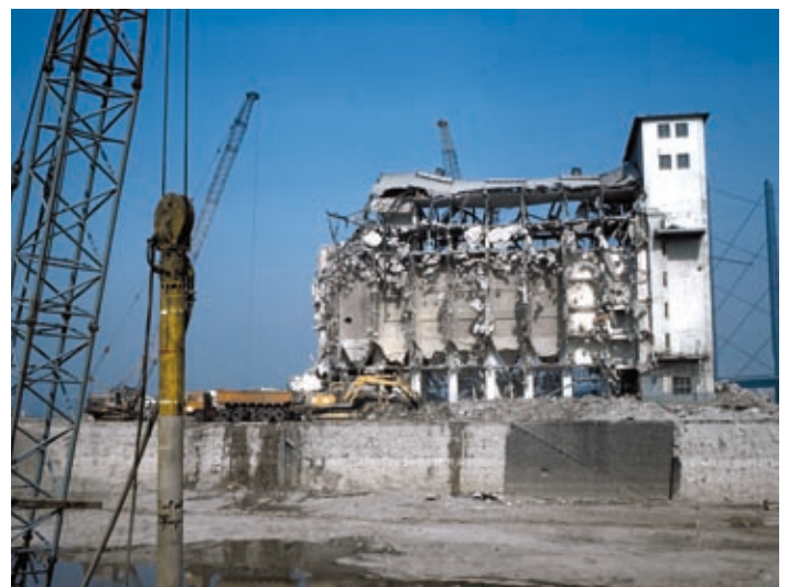
Abbruch der Hafengebäude auf dem Landtagsgrundstück und im Bereich des späteren Rheinparks Unterbilk, 1981
