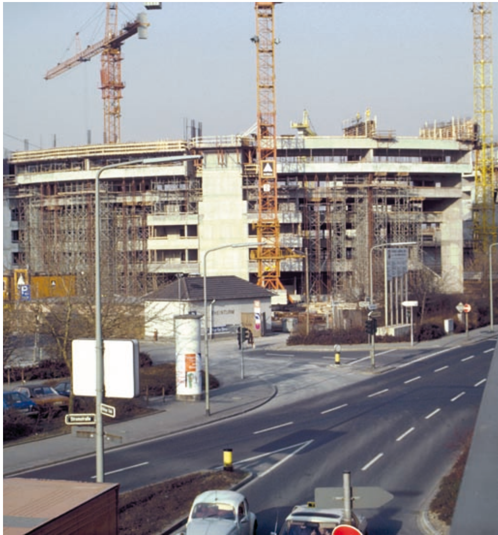
Rohbau von der Hochstraße aus gesehen, 1983
