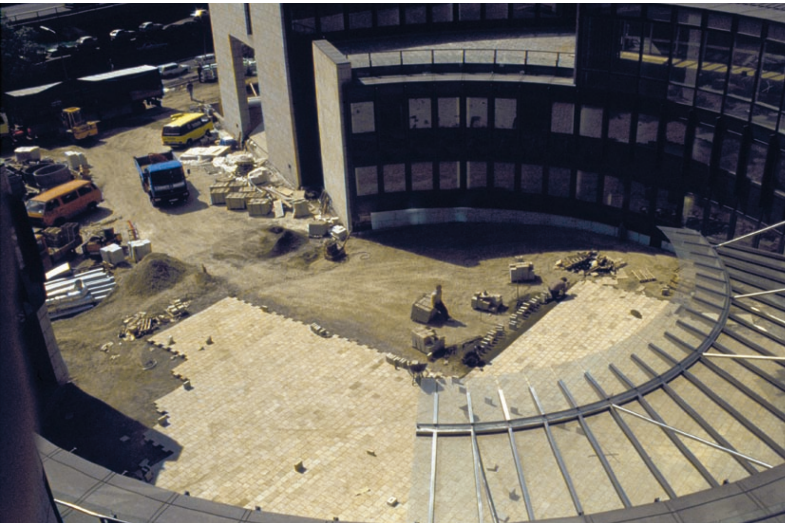
Plattierungsarbeiten vor dem Haupteingang, 1987
