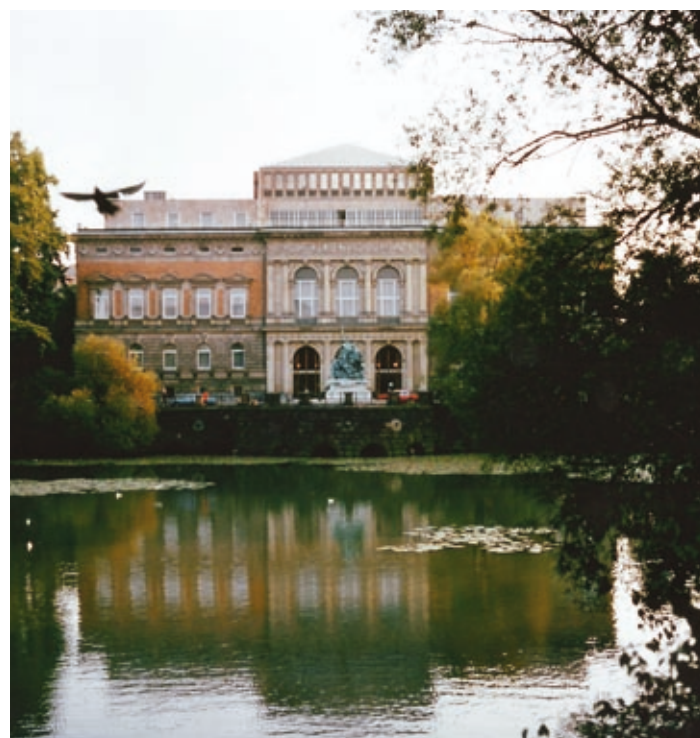
Vorderansicht nach dem Dachausbau des Ständehauses, 1980
