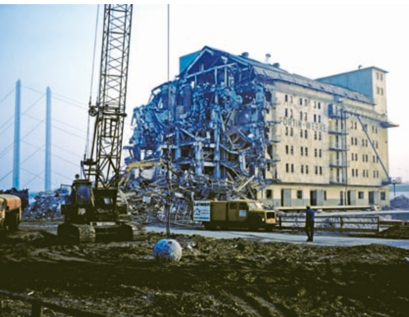
Abbruch der Hafengebäude: Getreidemühle Fortin an der Stelle des heutigen Plenarsaals, 1981
