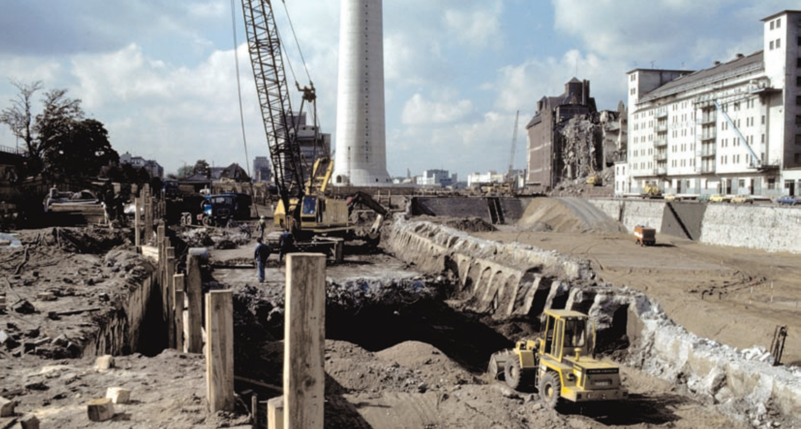
Baugrube, Abbruch der Mole auf der Stadtseite mit Blick auf den Fernmeldeturm und das Hafengebäude von Fortin und Rhenus, 1981
