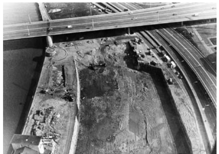
Bauplatz nach Verfüllung der Baugrube, 1982
