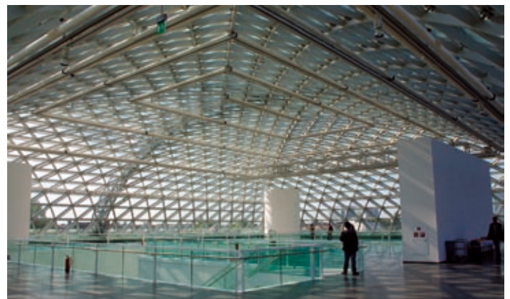
Dachgeschoss des zur Kunstsammlung K 21 umgebauten Ständehauses
